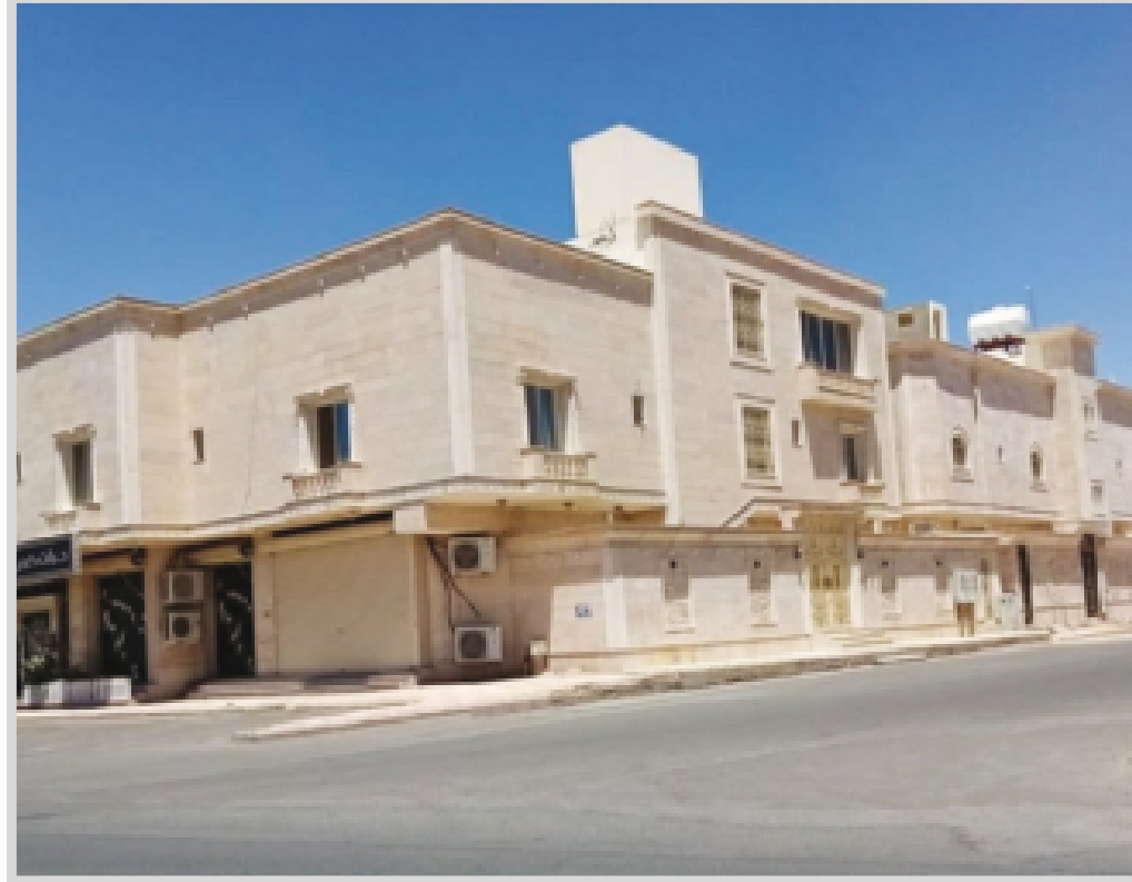
عمارة سكنية خلف البنك الأهلي في المدينة المنورة
