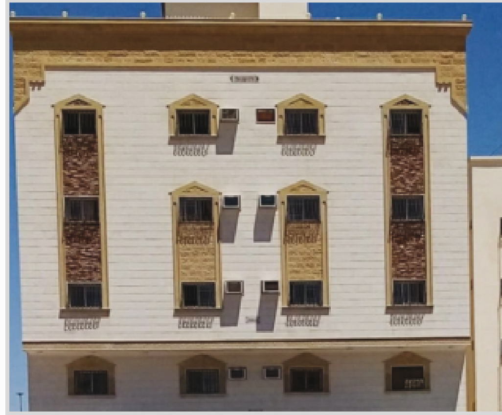
عمارة سكنية خلف البنك الأهلي في المدينة المنورة
