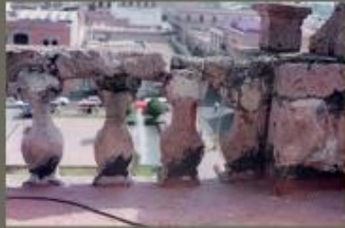
Desintegración de balaústres
