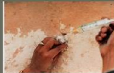
Inyección de fisuras
