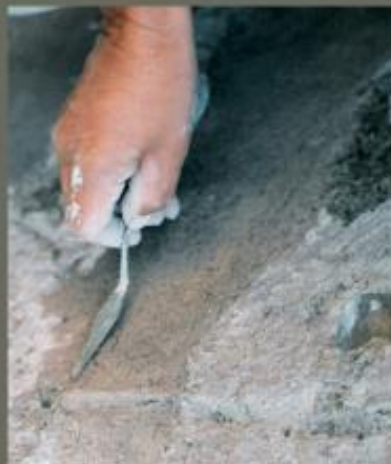
Aplicación de junta
