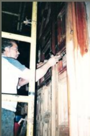
Retiro de diversas capas de material
