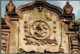
Degradación de juntas
