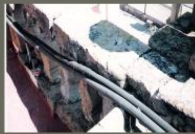
Desintegración de balaústres
