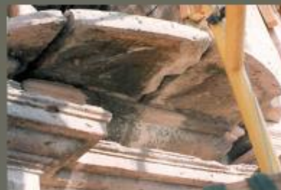
Degradación de juntas
