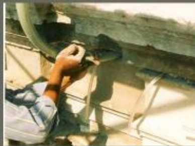
Inyección por gravedad
