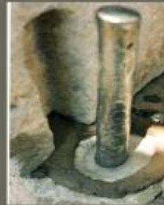
Colocación de perno metálico y recubrimiento de plomo
