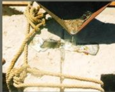
Colocación de perno metálico y recubrimiento de plomo
