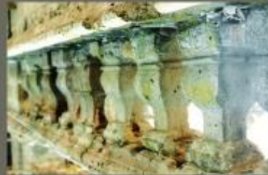
Desintegración de balaústres
