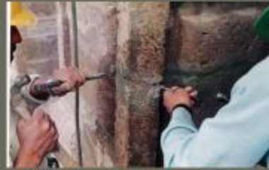
Liberación de juntas degradadas
