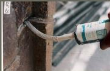
Inyección de juntas
