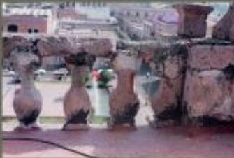
Desintegración de balaustrados
