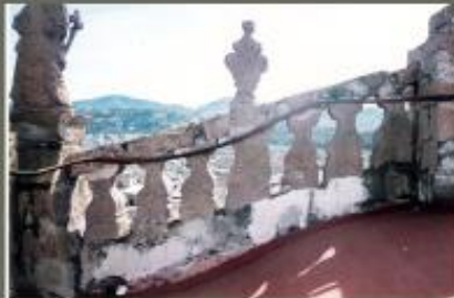
Desintegración de balaústres
