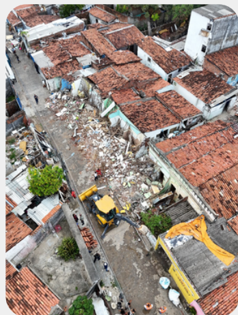
Demolição em andamento
