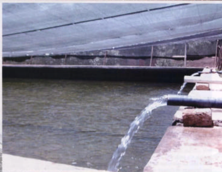
Figure 8. Manomètres placés à l'entrée et à la sortie du filtre à lamelles. Figure 9. Bassin d'accumulation d'eau d'oued
