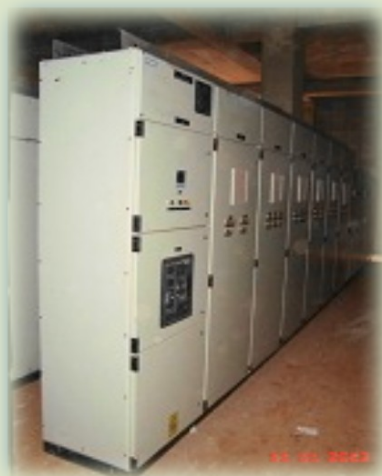
PAINÉIS DE ACIONAMENTO DA MÁQUINA DE PAPEL MP1, SIEMENS, avariado na importação
