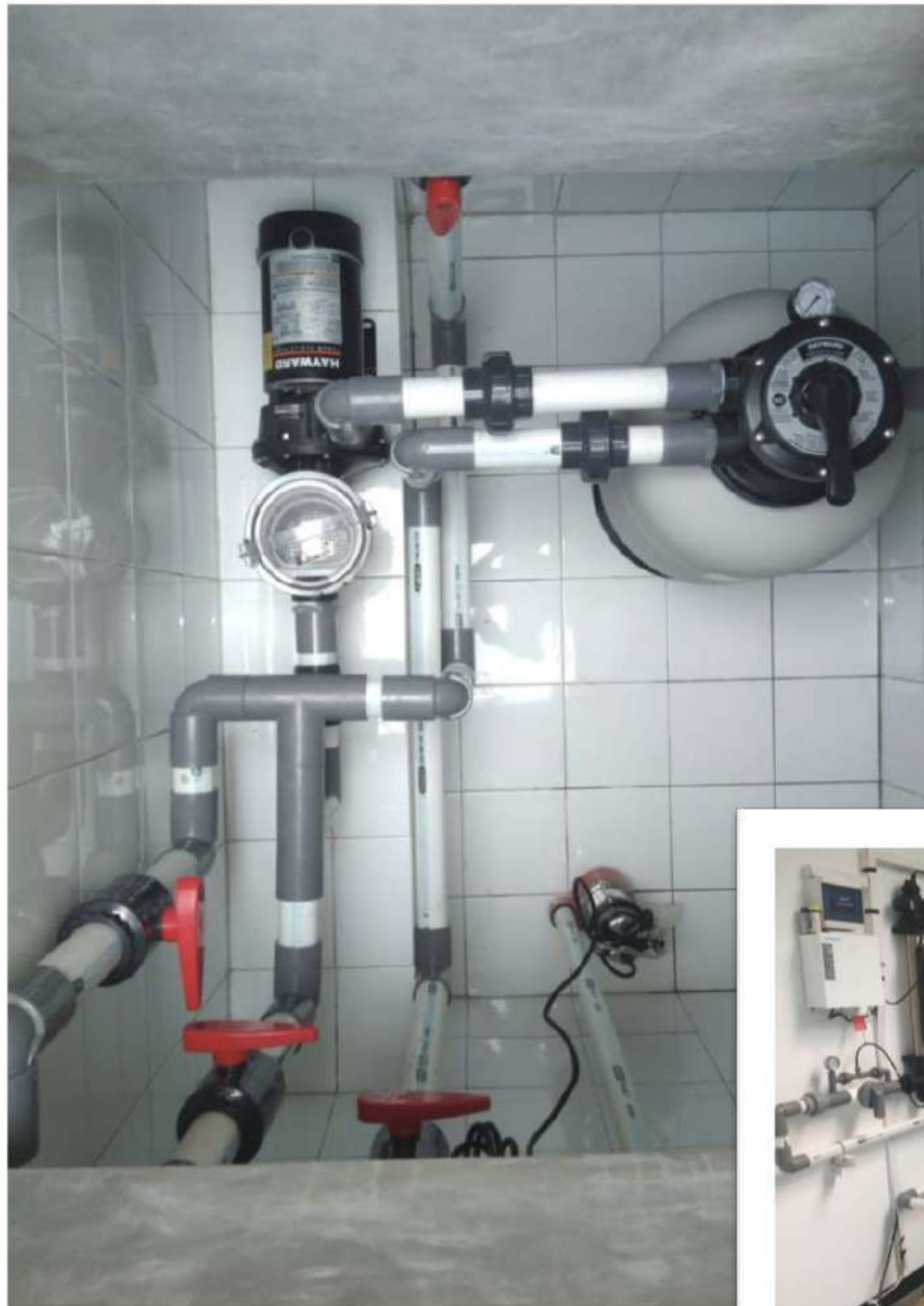
Instalasi Mesin Rumah Pak Husein, Taman Ratu-Jakarta Barat.
