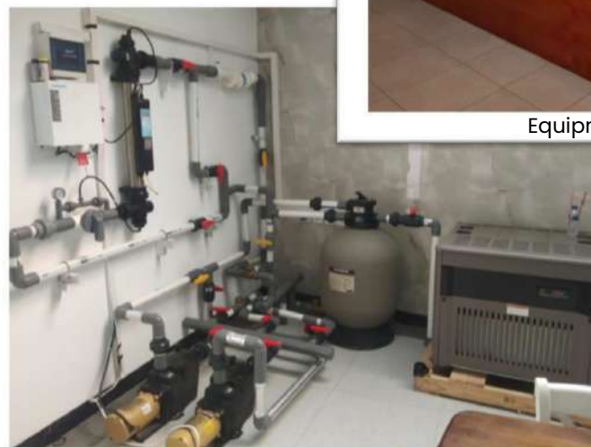
Instalasi Mesin Rumah Pak Asa, Palembang.
