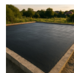
Proyek renovasi lantai (baru atau renovasi).
