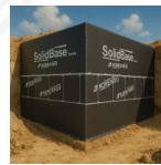
Dinding atau ruangan bawah tanah.
