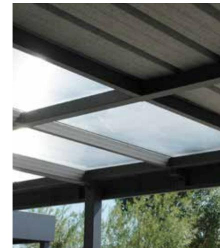
Bac acier classique, Bac acier isolé, polycarbonate pour laisser passer la lumière... ou encore un mix bac acier / polycarbonate ! Les choix sont multiples.
