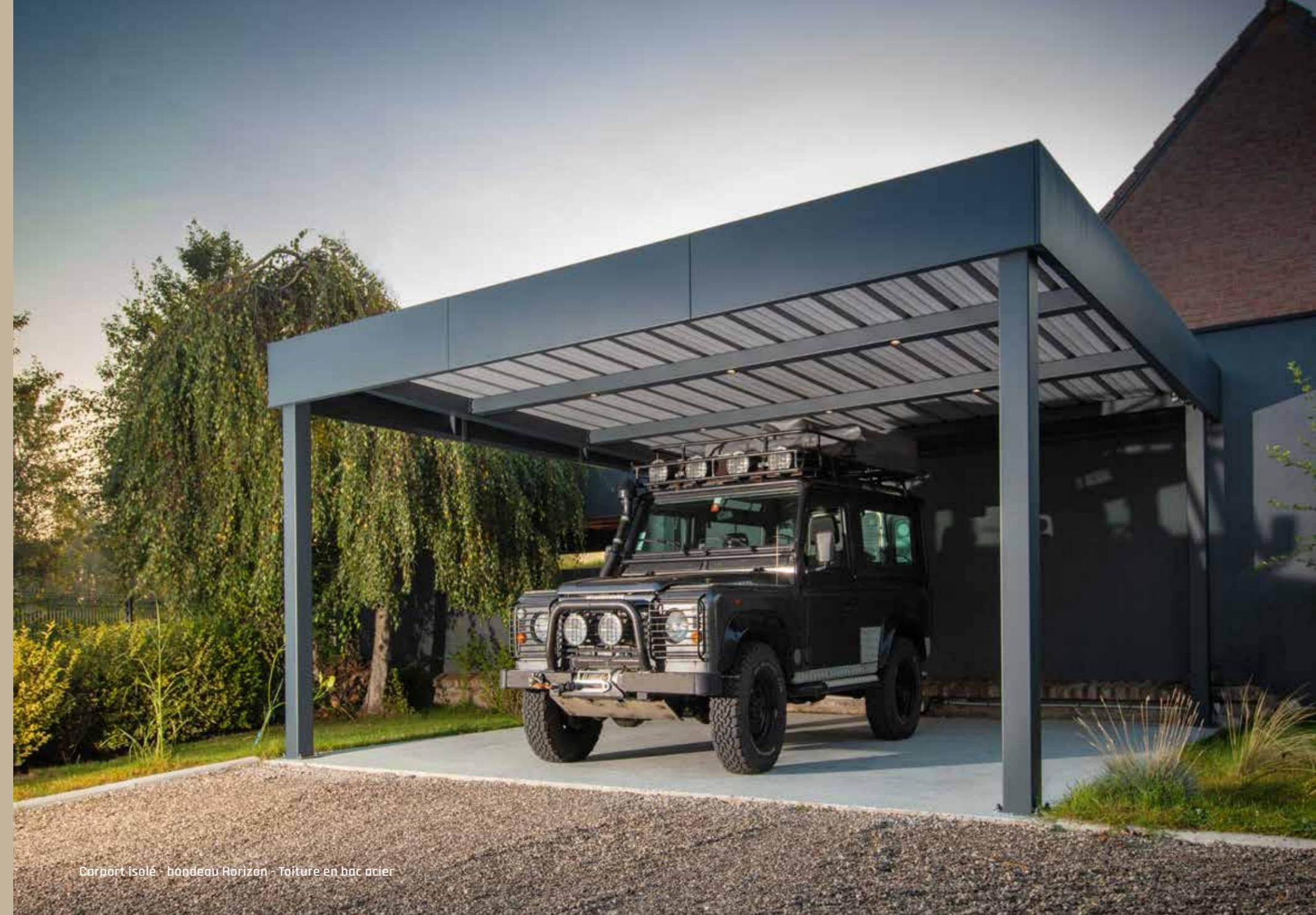
Carport isolé - bandeau Horizon - Toiture en bac acier
