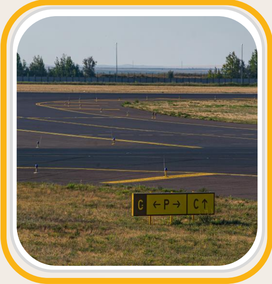
Instalación de Equipos
