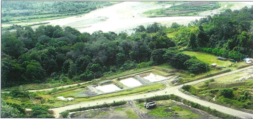
Gambar 2.4. WMP 04B untuk mengelola kegiatan pemompaan air tambang
