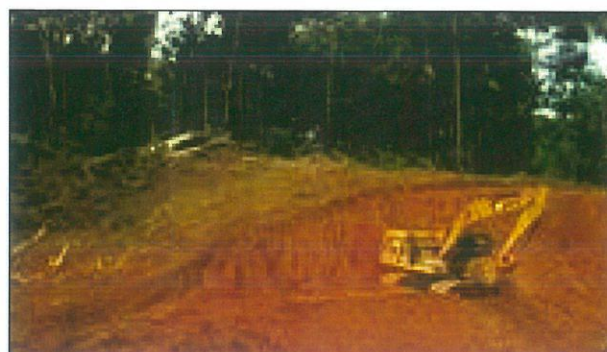
Gambar 2.3. Kegiatan pengupasan tanah pucuk
