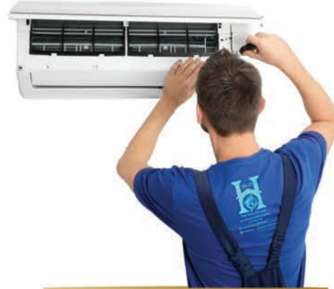
أجهزة تكييف الهواء
