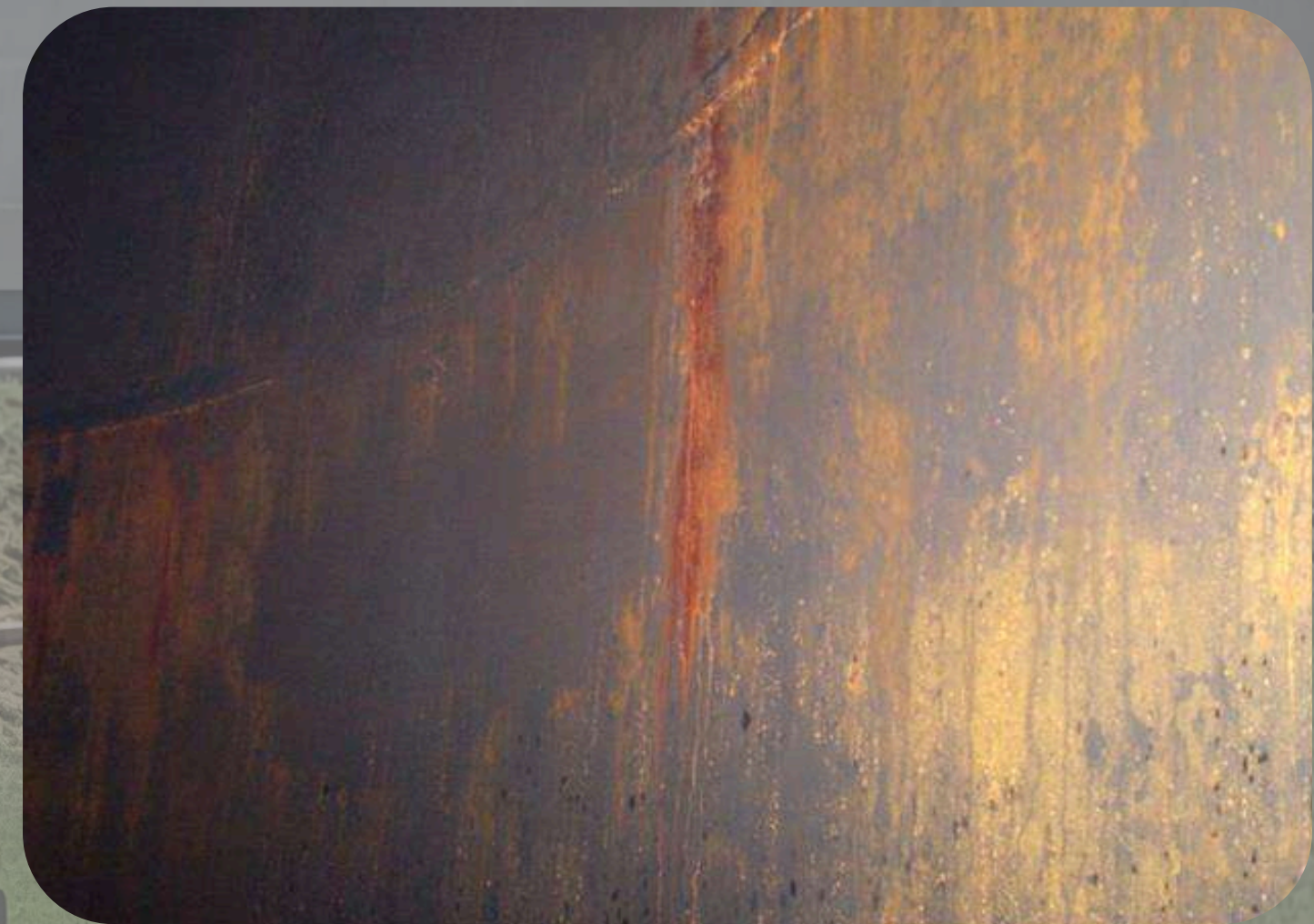
TANQUE DE GASOLEO COM CATALIZADOR - APÓS CIRCULAÇÃO QUÍMICA
