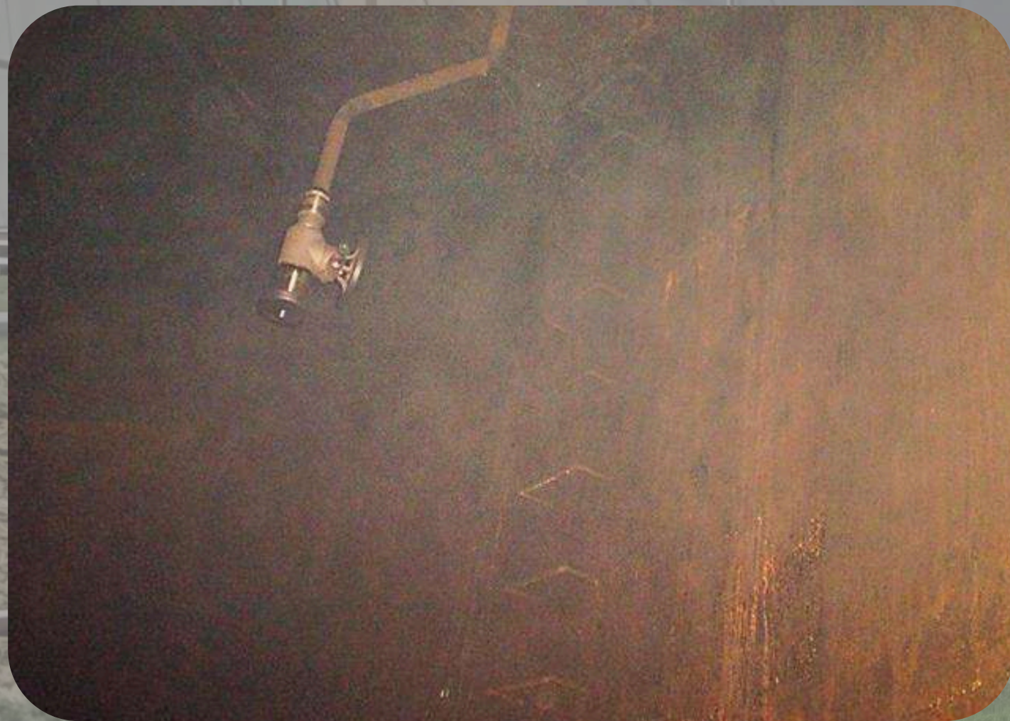
TANQUE DE NAFTA APÓS CIRCULAÇÃO QUÍMICA
