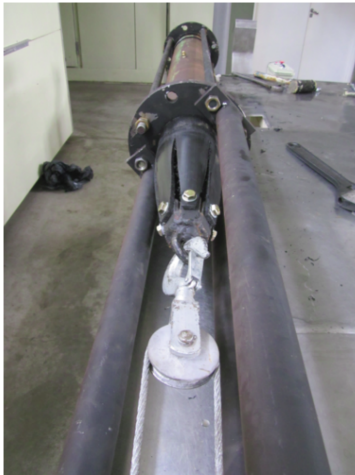
Figura 45: 'Liner' insetado en la tubería receptora con su extremo mecanizado en forma de 'pétalos' y unido al malacate.
