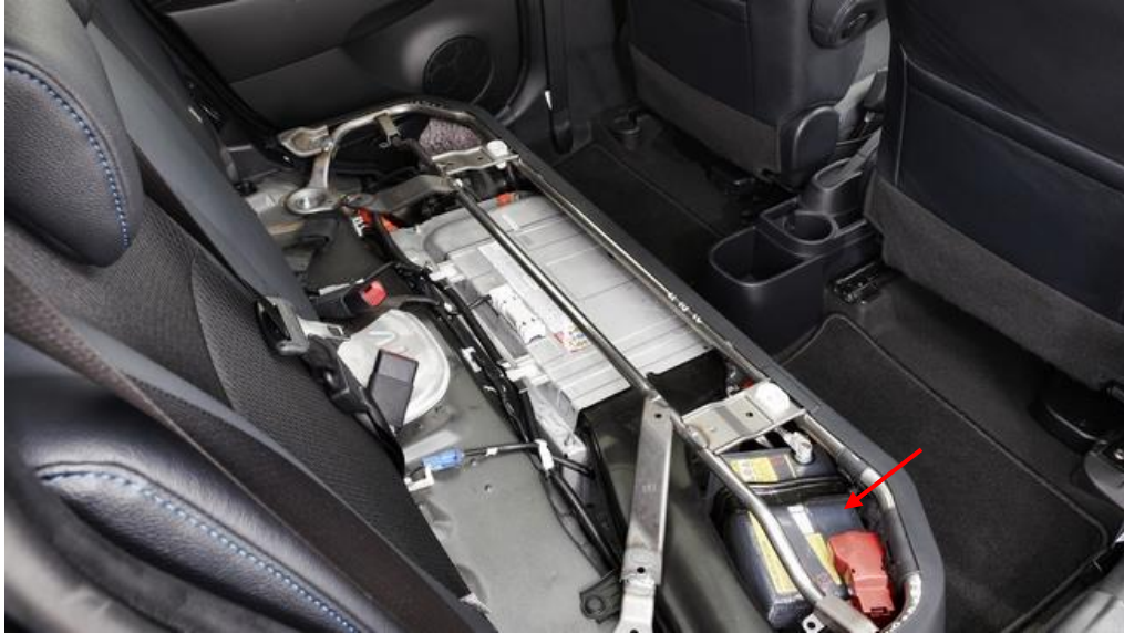
صورة توضيحية لموقع بطارية الجهد المنخفض في سيارة كهربائية
