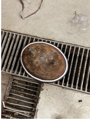
Görsel 1 – Manhole kapağı temizlendi, contalandı
