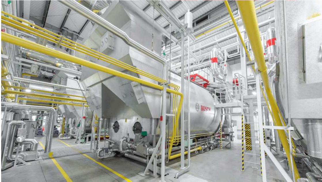
Şekil 1. Endüstriyel buhar kazanı ve baca gazı ekonomizörü (Bosch). Atık gaz ısıyı geri kazanılarak verim artırılır ve işletme maliyeti azalır[14][12].
