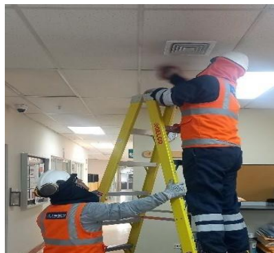
Limpieza de rejillas difusores y líneas de retorno del sistema de calefacción y ventilación
