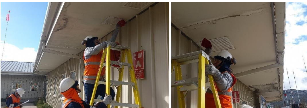
Limpieza de rejillas de inyección de aire y extracción del sistema de ventilación
