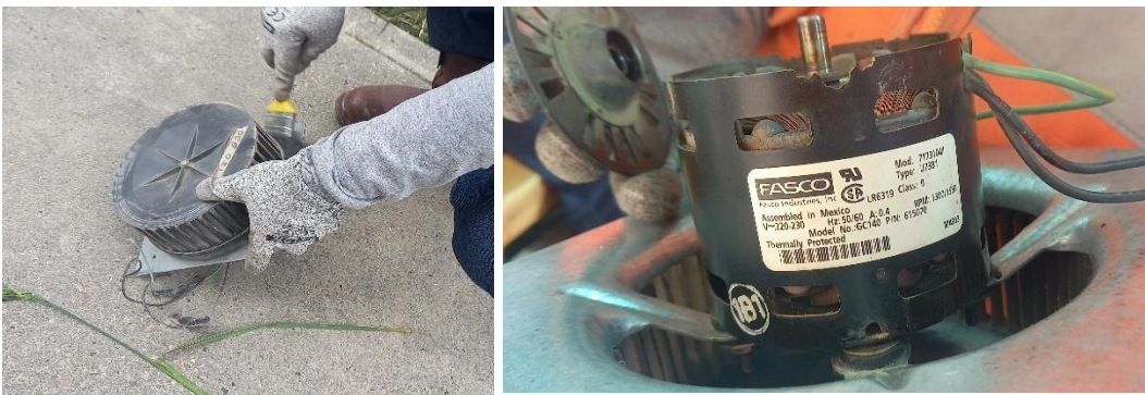
Se realizó limpieza general del motor eléctrico y lubricación
