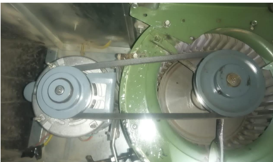
Se cambió faja de transmisión a los ventiladores
