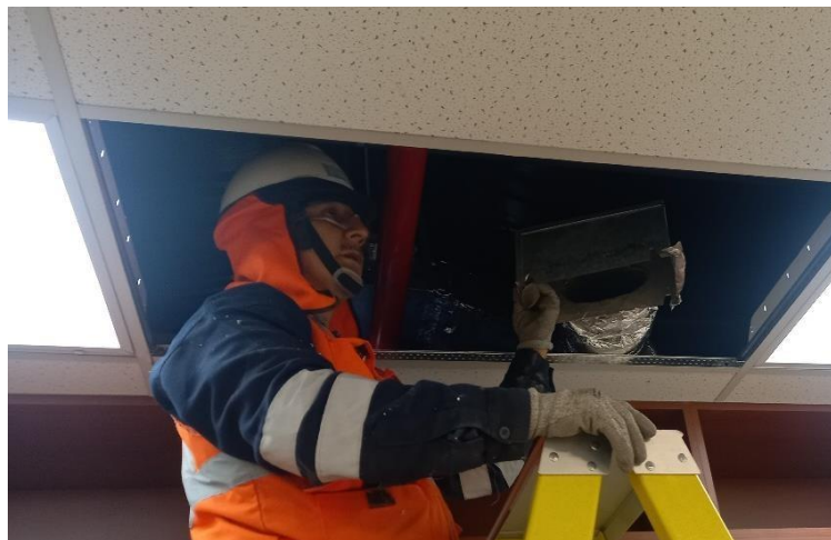
Se verifico sistemas de ductos y se realizo correcciones
