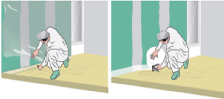
Figure 2 : Réalisation de la désolidarisation périphérique
