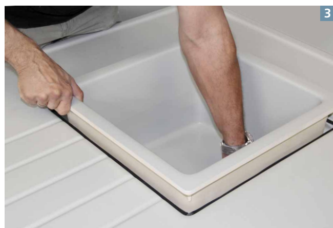
inserting and fixing the sink / Becken einsetzen und verfugen
