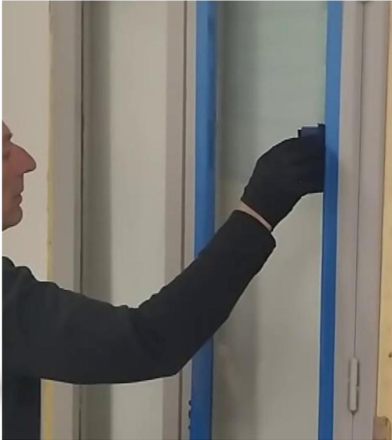
Appliquer uniformément le produit sur la surface du verre. Faites un X sur le support du haut à gauche vers le bas à droite puis du bas à gauche vers le haut à droite.
