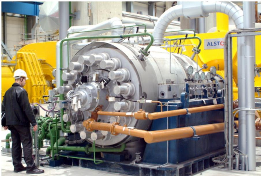
FIGURE 9.1 – Photo d'une pompe du fabricant KSB menant  $2500 \text{ t h}^{-1}$  d'eau à 350 bar dans une centrale à vapeur.
