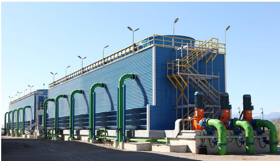
FIGURE 9.7 – Condenseur avec cheminées de refroidissement intégrées.
