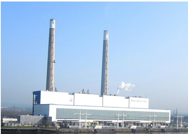
FIGURE 9.22 – Centrale électrique de Porcheville, alimentée au charbon jusqu'en 1987 et fonctionnant désormais au fioul. Elle sert principalement les demandes de pointe.
