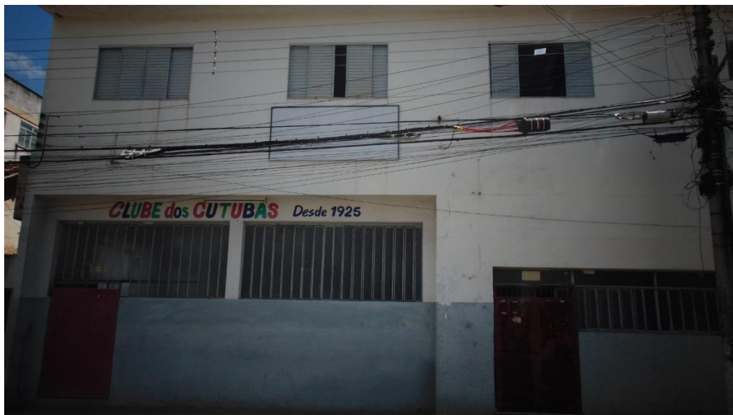
IMAGEM 4 - Fachada do Clube dos Cutubas
