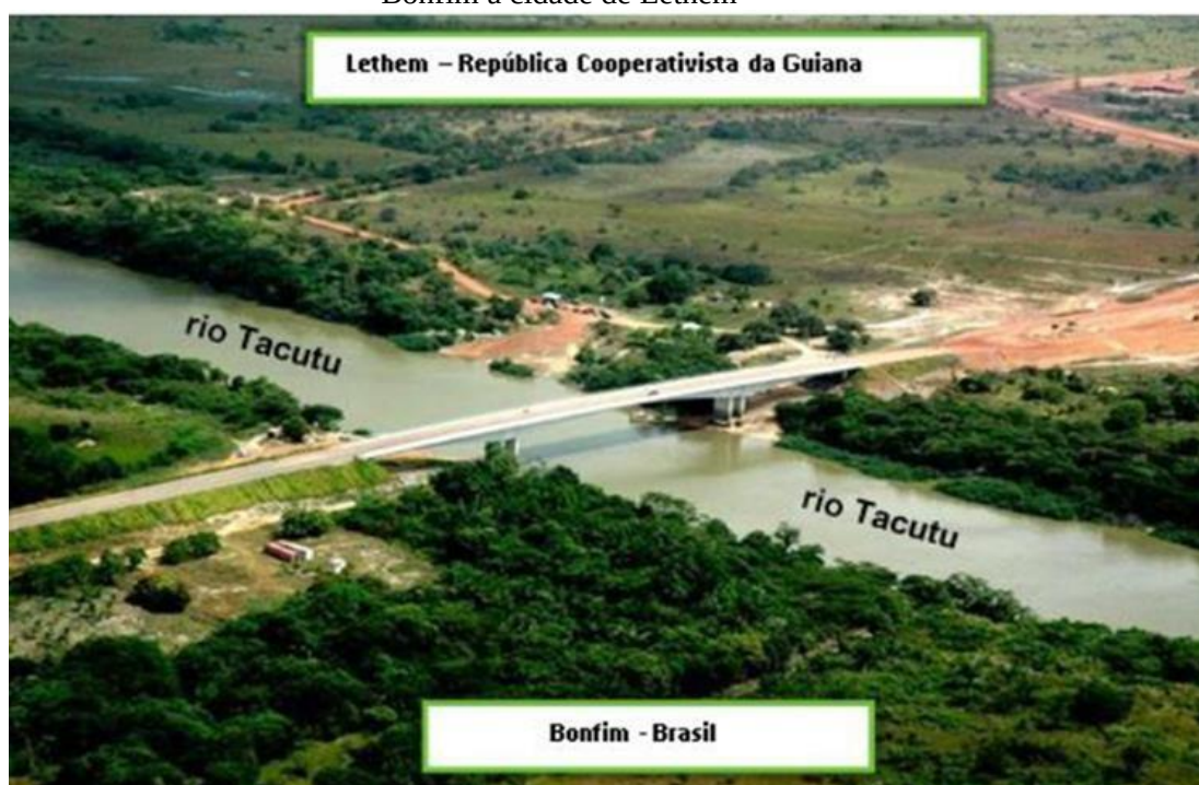
Imagem 9 – Ponte Binacional Prefeito Olavo Brasil Filho sobre o rio Tucutu, interligando Bonfim à cidade de Lethem
