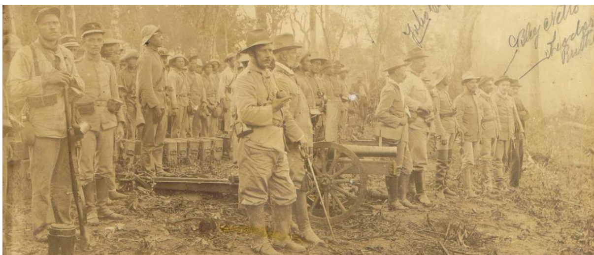
Figura 11 - Tropas com seu canhão Krupp de montanha 75 mm L/14 de tiro rápido, modelo 1906. Como podia ser dividido em fardos, foi bastante utilizado durante a Guerra do Contestado (1912-1916) devido a sua facilidade de transporte em terrenos acidentados.
