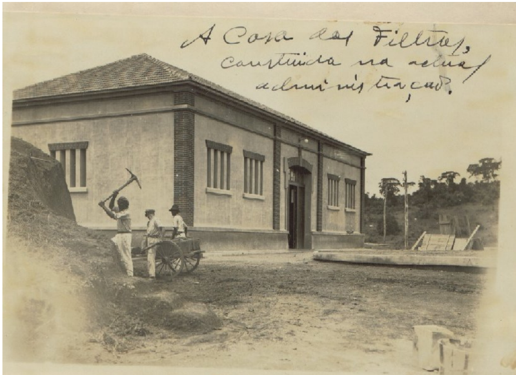
Foto mostrando a Casa dos Filtros, em Cataguases.
