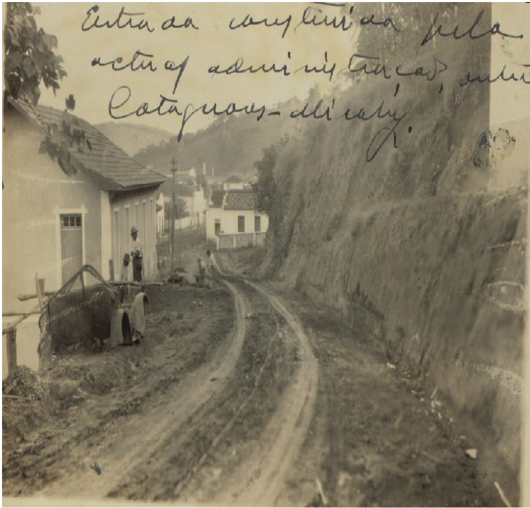
Construção da estrada que liga Cataguases a Mirai. Fonte: Processo CAT-1-CR-3918, arquivado no CDH de Cataguases.
