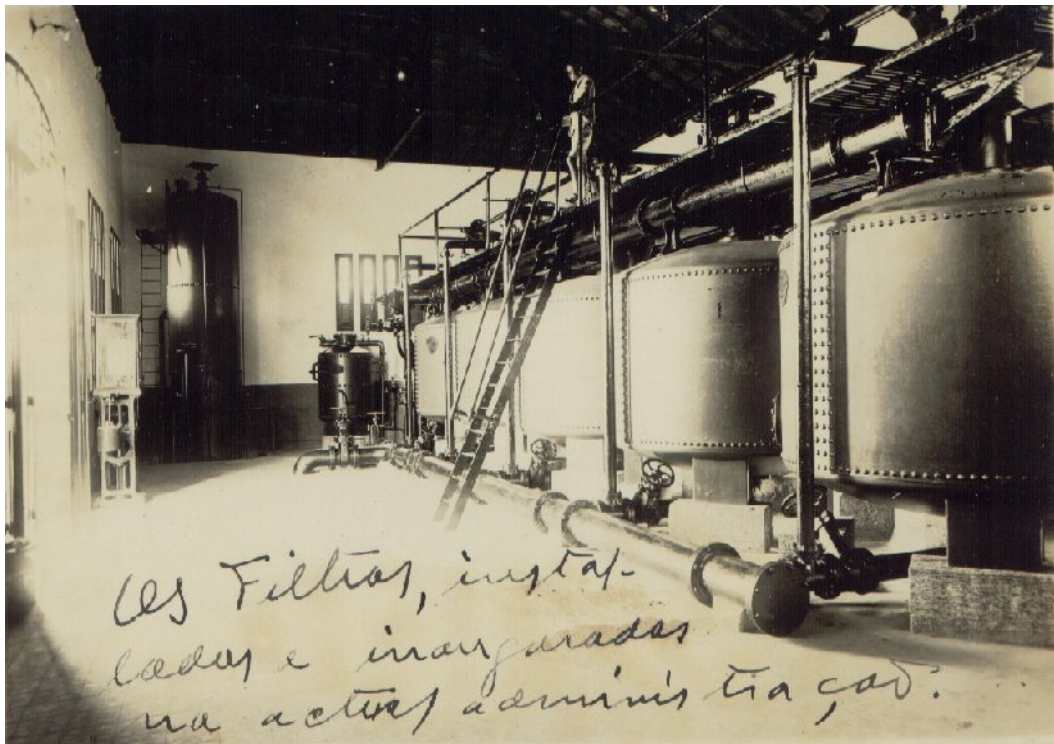
Foto mostrando a instalação da casa dos filtros, em Cataguases, e dos equipamentos que a compunham. .
