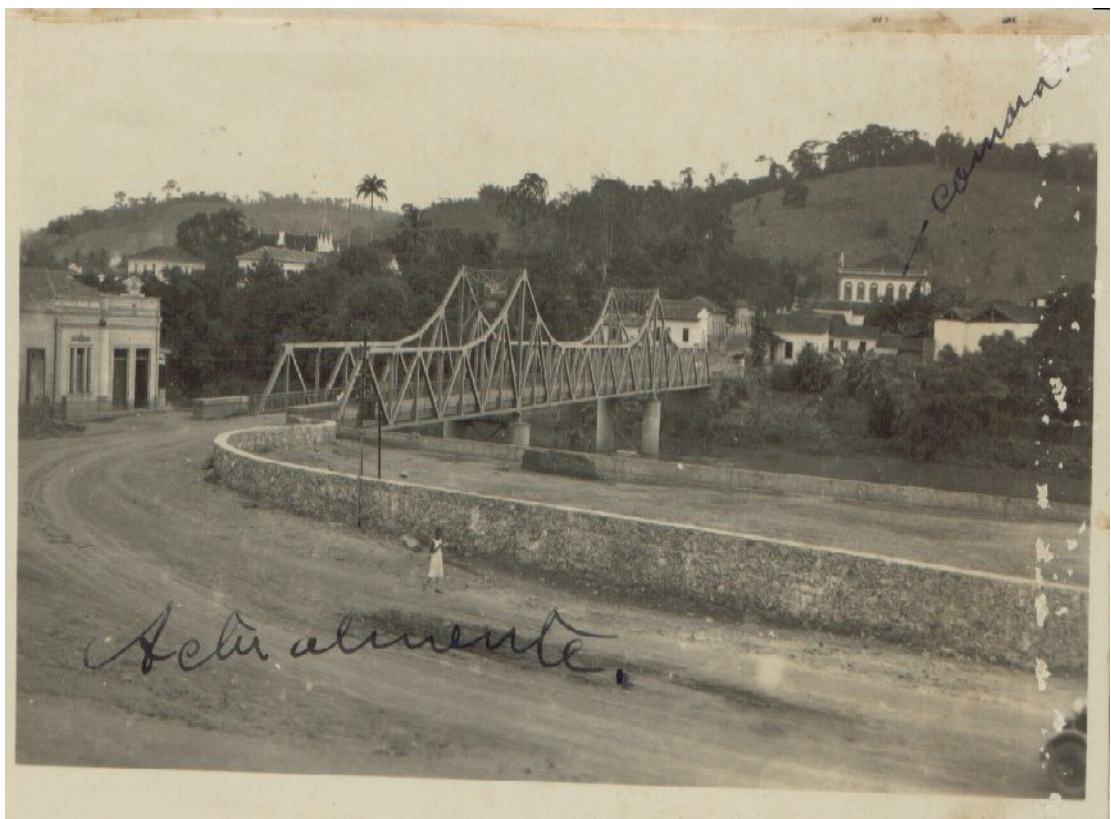
Foto mostrando a construção de uma ponte em Cataguases. Fonte: Processo CAT-1-CR-3918, arquivado no CDH de Cataguases.
