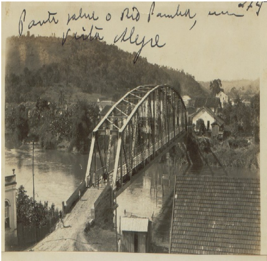
Foto mostrando as obras feitas no Distrito de Vista Alegre, Município de Cataguases. Fonte: Processo CAT-1-CR-3918, arquivado no CDH de Cataguases.
