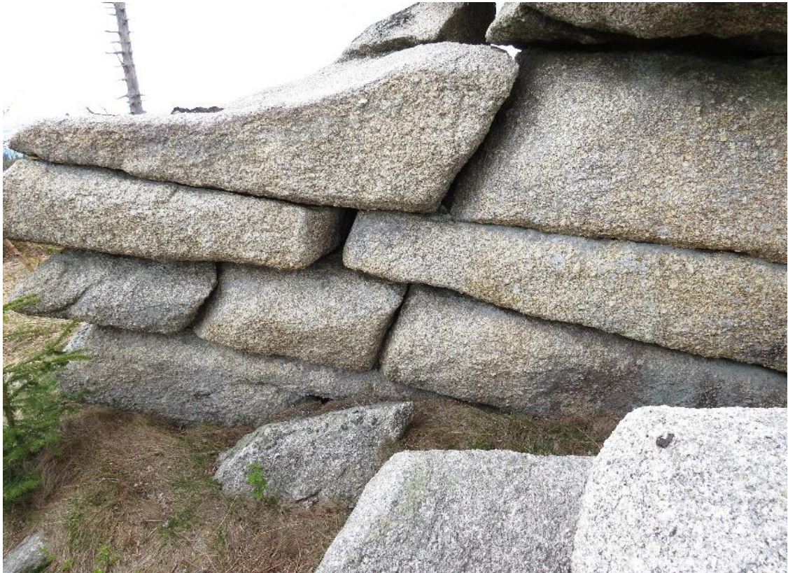
Bild 10: Mauerwerk im „Versatz“ gelegt.
