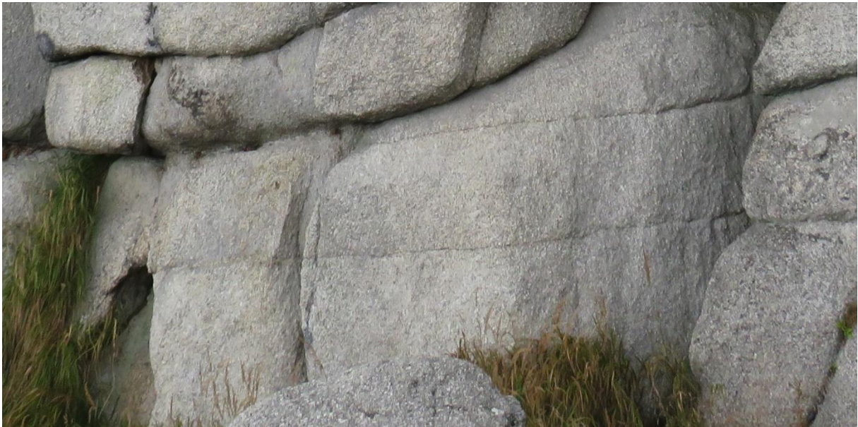
Bild 47: Detail der Mauerfugen.
