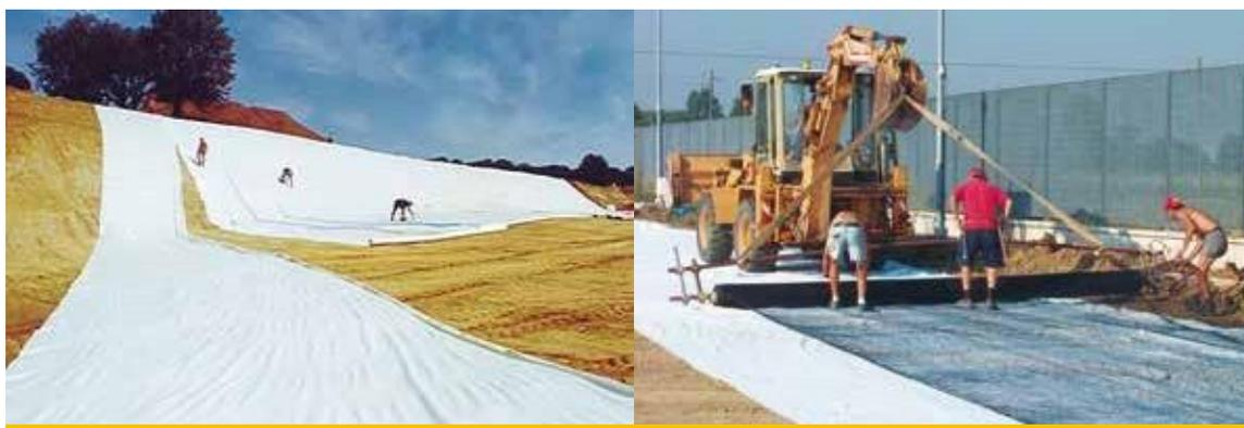
Geotextil no tejido 100% poliéster cohesionado mecánicamente por agujeteado en bolsas de 20 m<sup>2</sup>.
