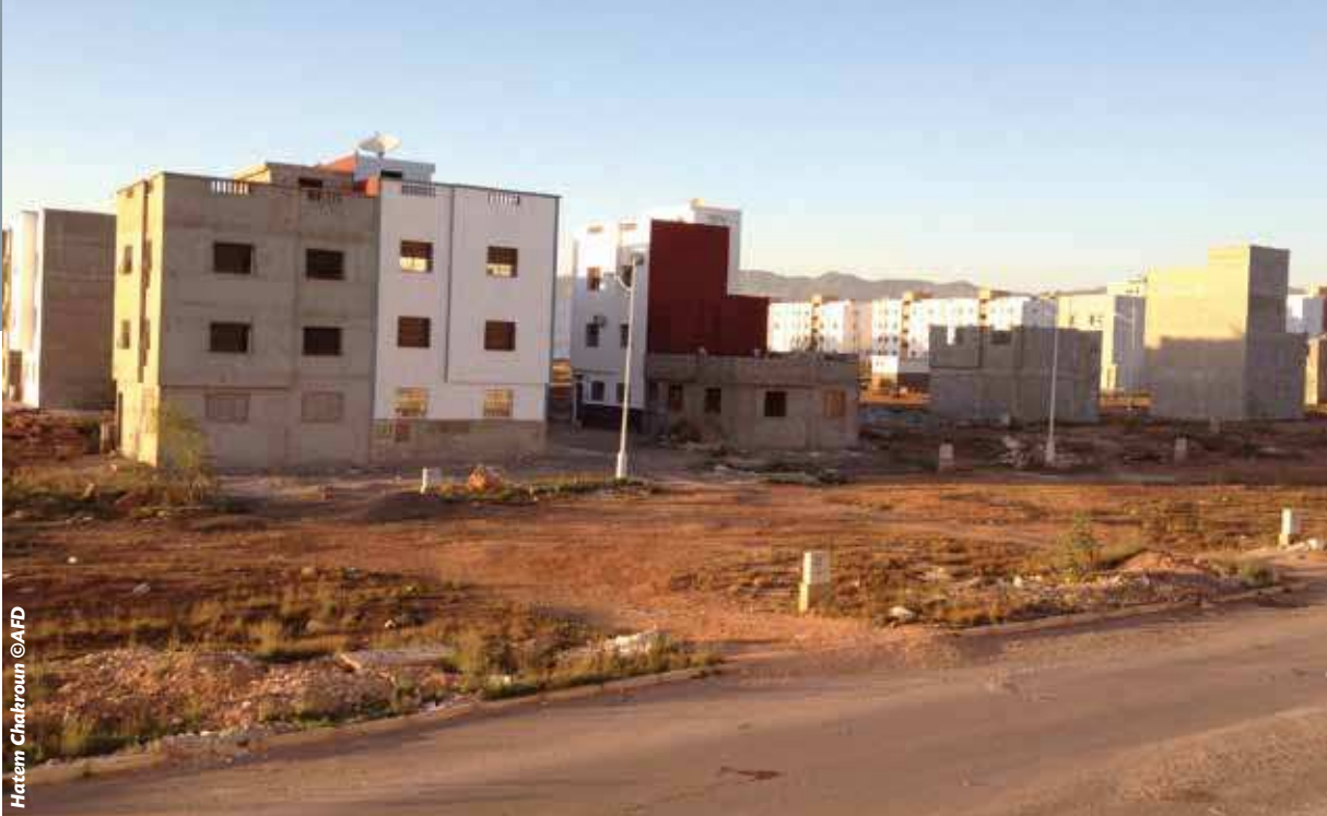
Quartier en construction à Agadir (Maroc)
