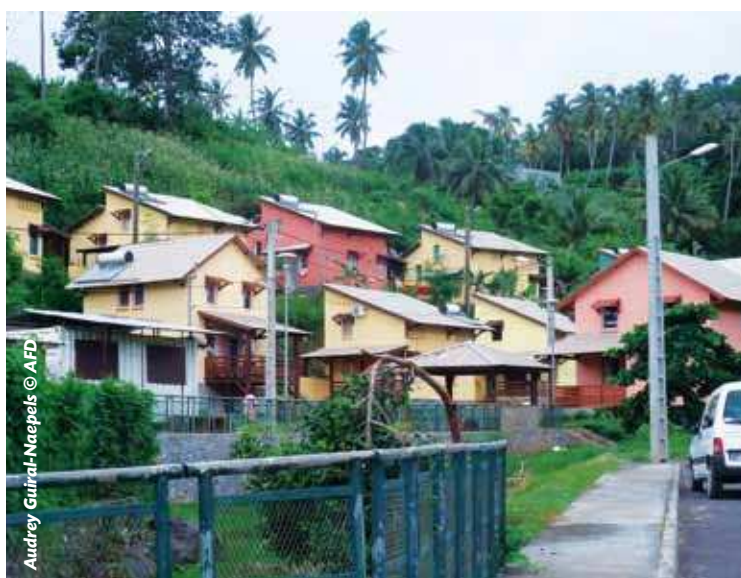
Opération de Résorption d'Habitat Insalubre, Logement en accession très sociale (Mayotte)
