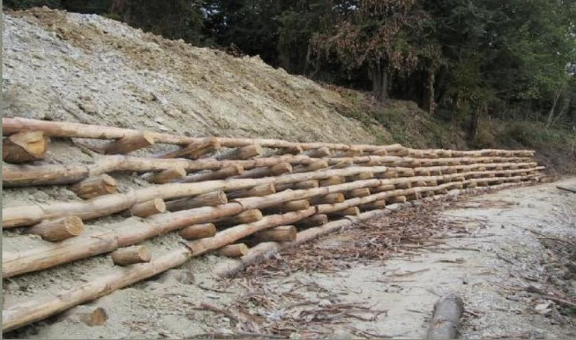
Palificate o Palizzate: ottime ma poco durevoli in condizione di saturazione costante dei terreni
