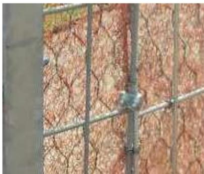
Ogni struttura lavora staticamente in modo indipendente (permettendone quindi l'applicazione a campioni) e comunque viene collegata e resa solidale con l'adiacente, mediante opportuni morsetti zincati ad alta resistenza.
