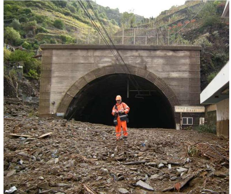
Dopo l'alluvione che ha interrotto la linea ferroviaria, restava il problema del terreno di risulta che poteva essere portato all'esterno solo con interruzione del traffico ferroviario. Con l'uso di SOSTengo è stato dissipato in loco.
