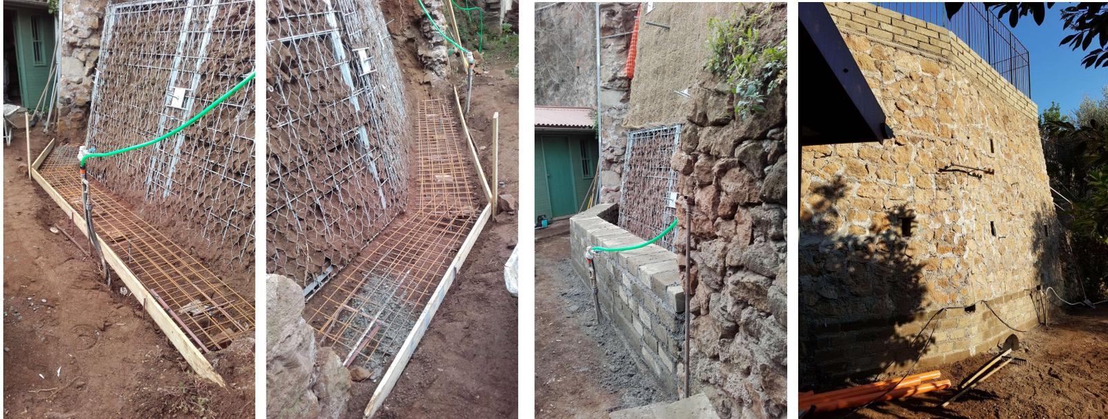
SOSTengo utilizzati con l'ausilio di tiranti sub-orizzontali per il consolidamento di un muro in pietra pericolante.
