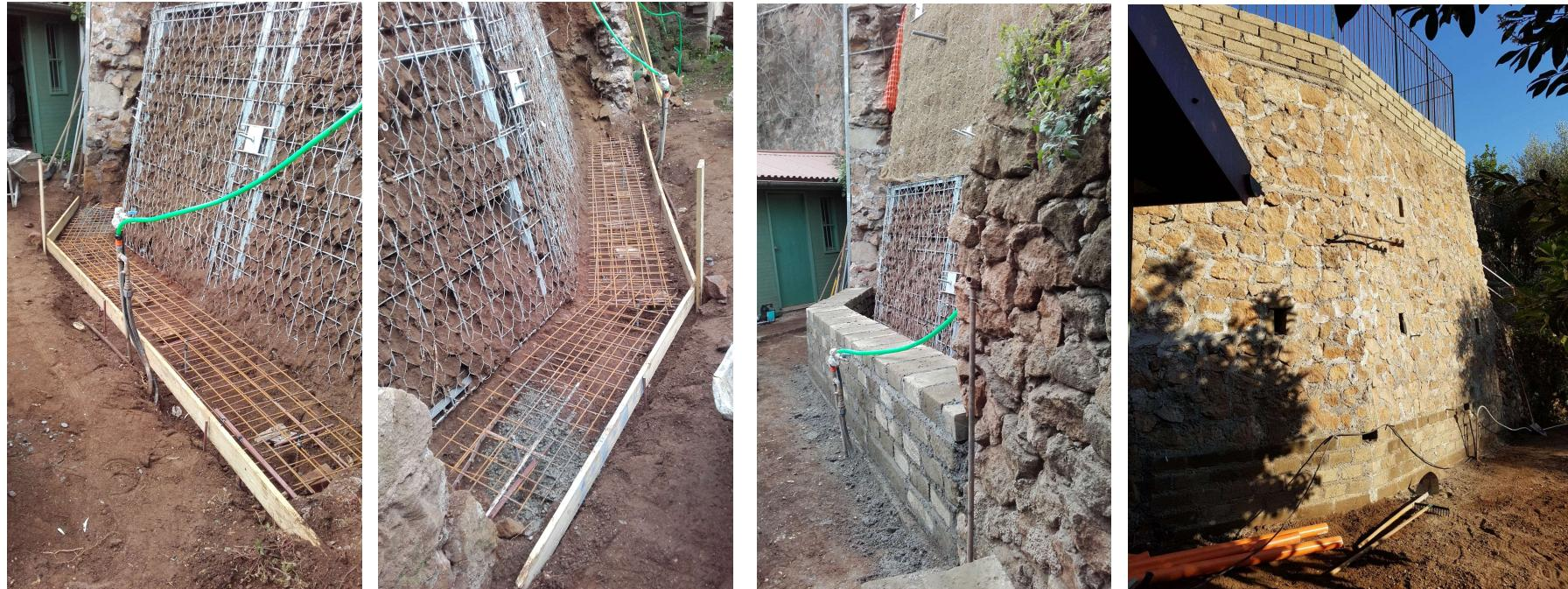
SOSTengo utilizzati con l'ausilio di tiranti sub-orizzontali per il consolidamento di un muro in pietrame pericolante.
