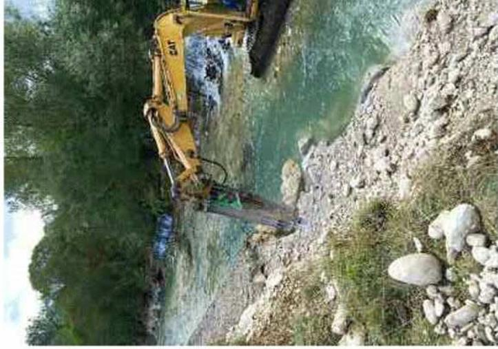
Ruspe in azione per demolire gli argini in cemento
