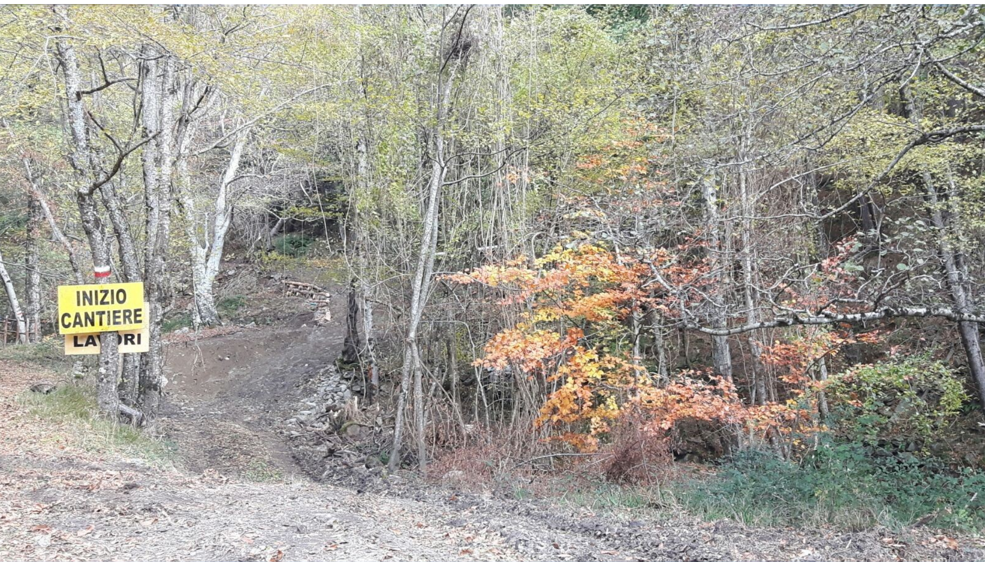
Foto 9 a – Località Imposto: dal guado 1: vista dell'area di cantiere a fine lavori (stato antecedente in Foto n. 1)
