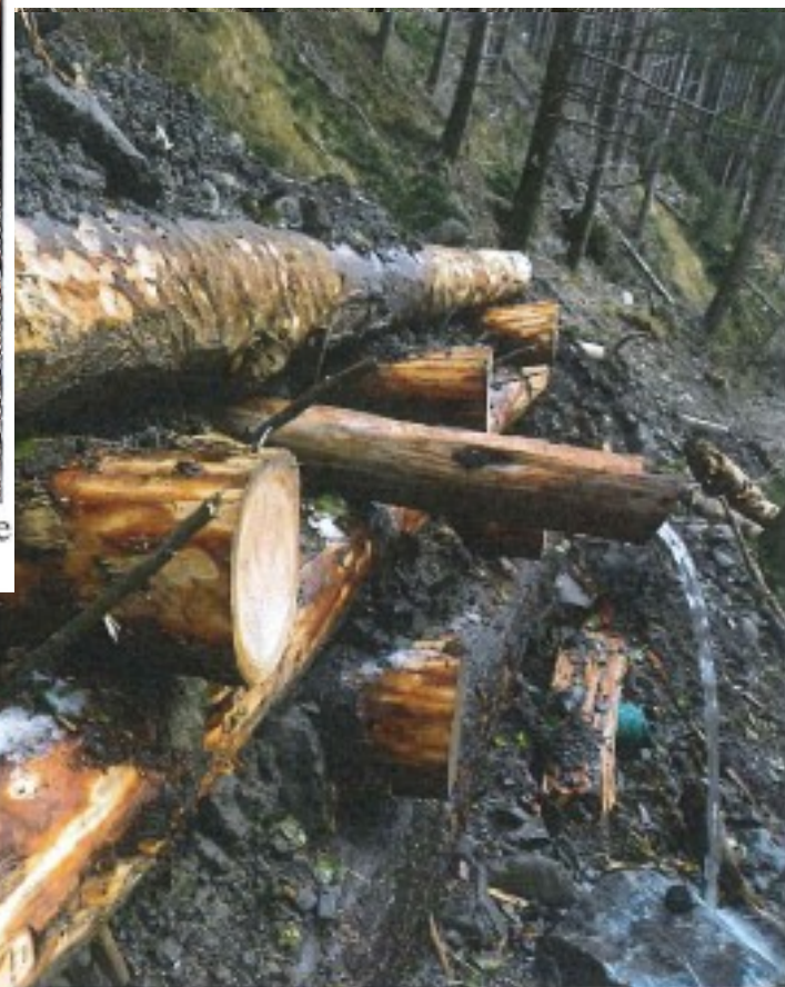
Foto 19 a – palificata per protezione al piede della strada: particolare del drenaggio sotto-strada in funzione
