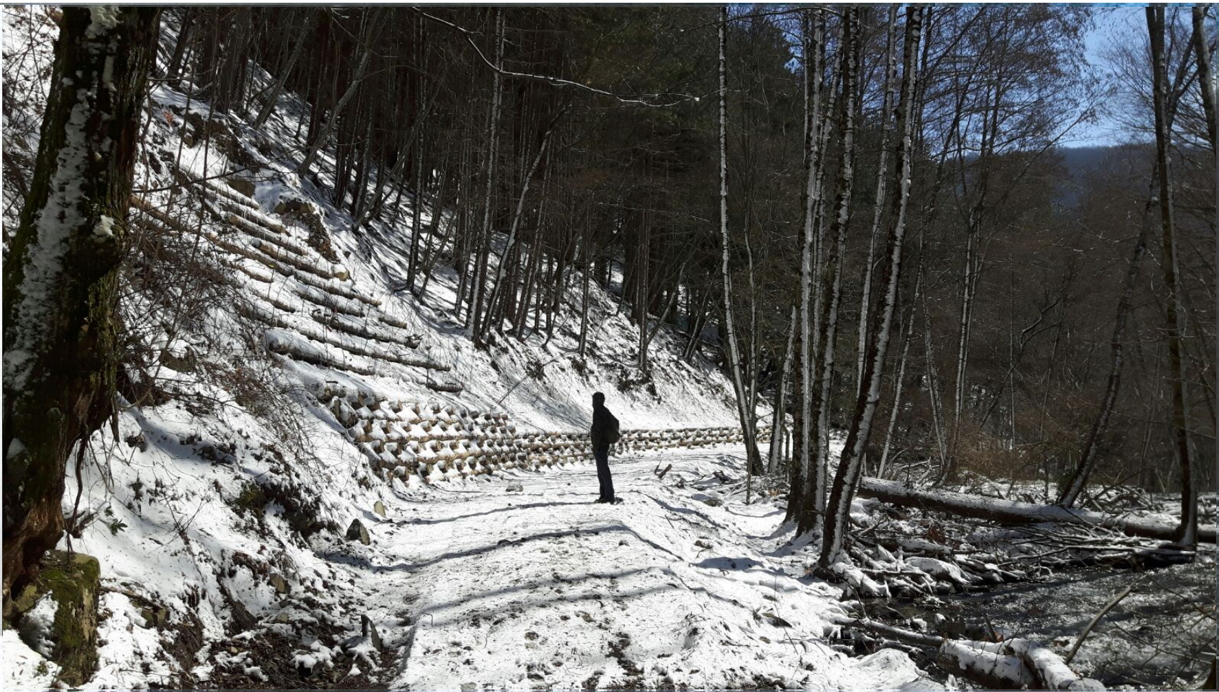
Foto 10 c –Palificate e grata viva durante una visita con Studenti dell'Università di Firenze
