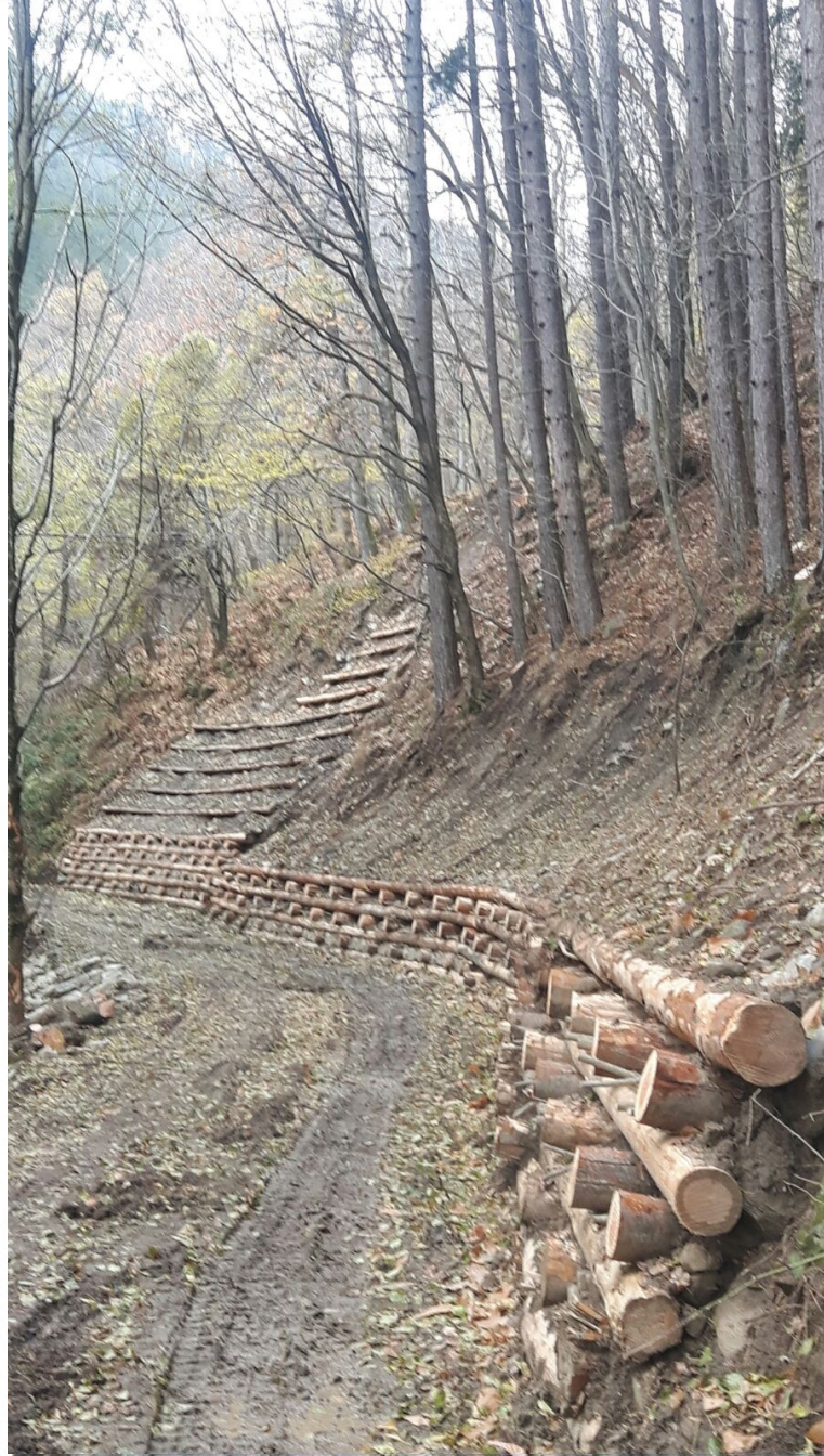
Foto 10 a – Palificata e grata vive con talee a fine lavori, prima dell'inserimento di piante radicate (stato antecedente in Foto n. 2 e 3)
