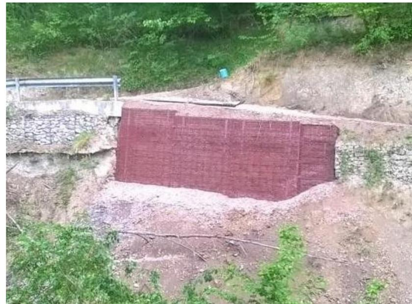
Sostituzione rapida di gabbionate franate (notare le differenze dimensionali)
