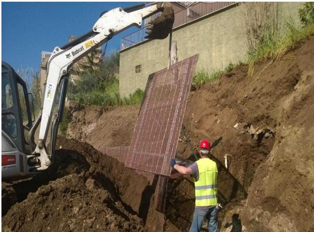
La struttura monolitica permette di evitare operazioni manuali dentro gli scavi durante la posa, eliminando ogni rischio per il personale.
