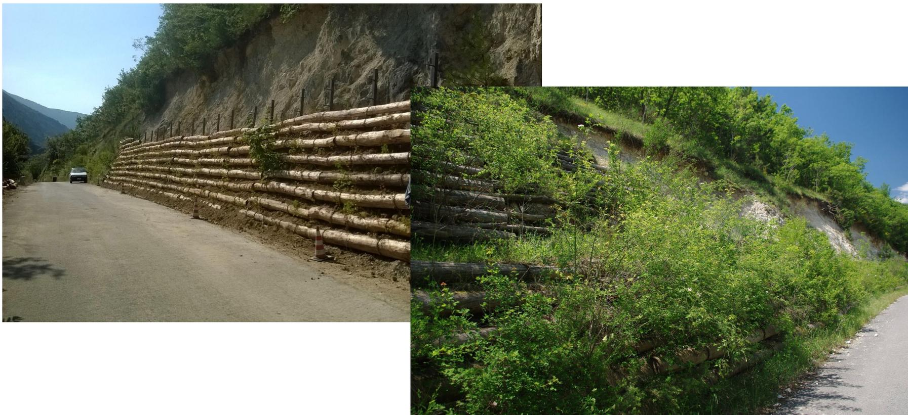
La **Loricata** si avvale della struttura in acciaio per un supporto durevole nel tempo e si riveste di pali in legno per un impatto ambientale molto basso. Le piante pian piano ricoprono gli elementi che scompaiono dalla vista pur mantenendo la loro funzione strutturale
