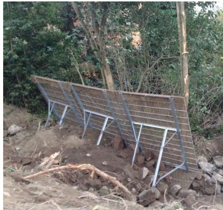
Il cuore della struttura è rappresentato dalla sua parte posteriore che, sfruttando il peso del terreno, ne permette l'ancoraggio.
