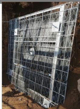
Il pannello viene ancorato in discesa durante le operazioni di scavo (tipo berlinese), con possibilità di recupero in salita, quando cessa la sua funzione portante. **La rapidità di esecuzione** in ogni condizione è uno dei punti di forza che fa di SOSgreen un prodotto validissimo nel campo delle emergenze e della Protezione Civile.
