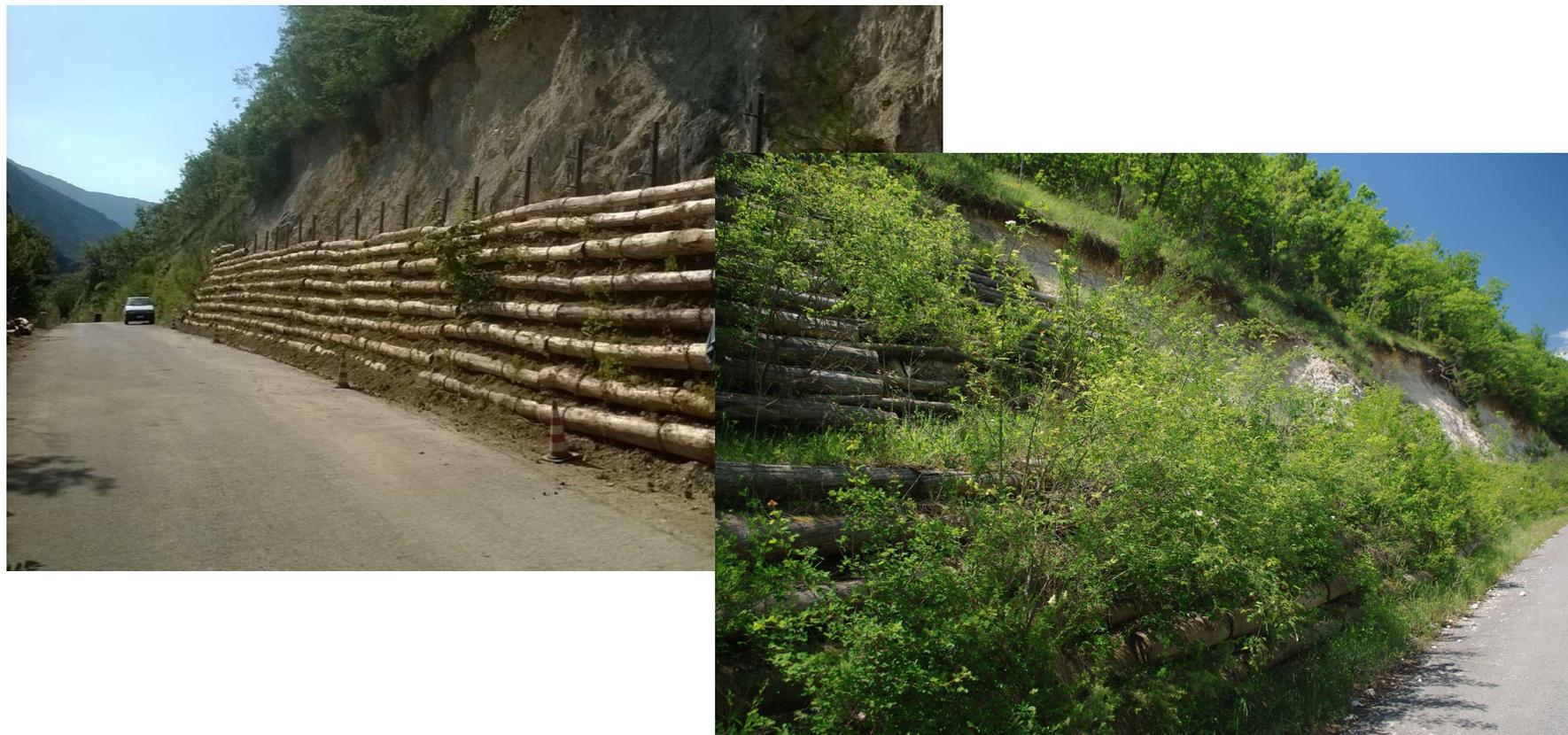
La **Loricata** si avvale della struttura in acciaio per un supporto durevole nel tempo e si riveste di pali in legno per un impatto ambientale molto basso. Le piante pian piano ricoprono gli elementi che scompaiono dalla vista pur mantenendo la loro funzione strutturale
