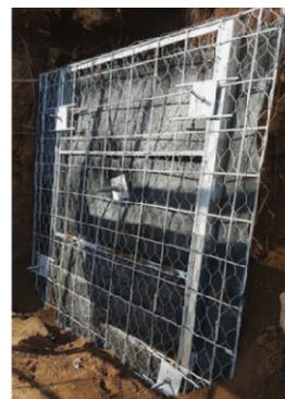
Il pannello viene ancorato in discesa durante le operazioni di scavo (tipo berlinese), con possibilità di recupero in salita, quando cessa la sua funzione portante. **La rapidità di esecuzione** in ogni condizione è uno dei punti di forza che fa di SOSgreen un prodotto validissimo nel campo delle emergenze e della Protezione Civile.
