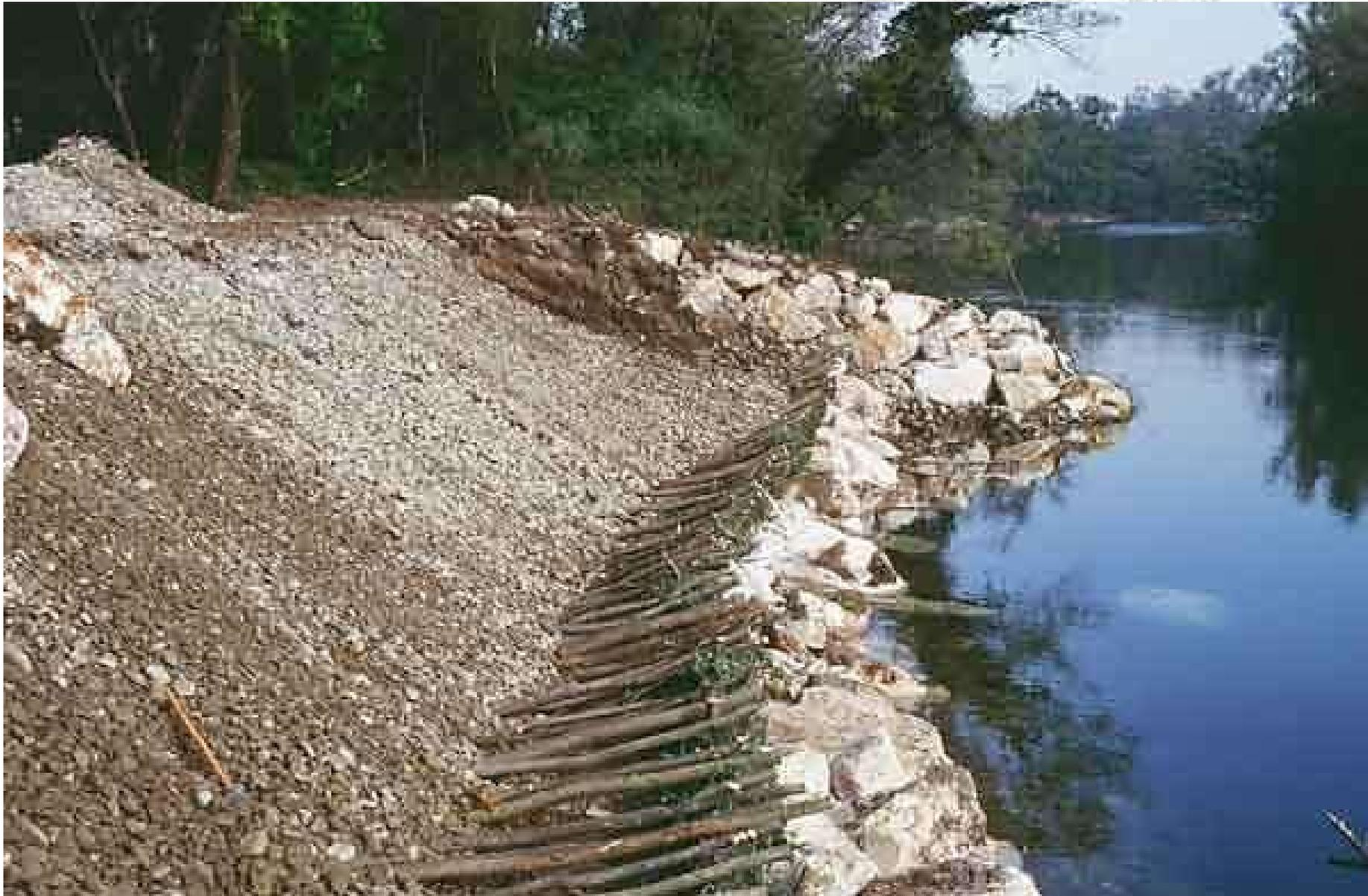
**Figura** - Ribalta viva completata lungo il Ticino in località Bosco Danico - Treccate (NO) (da R. Gazzola, 1982)
