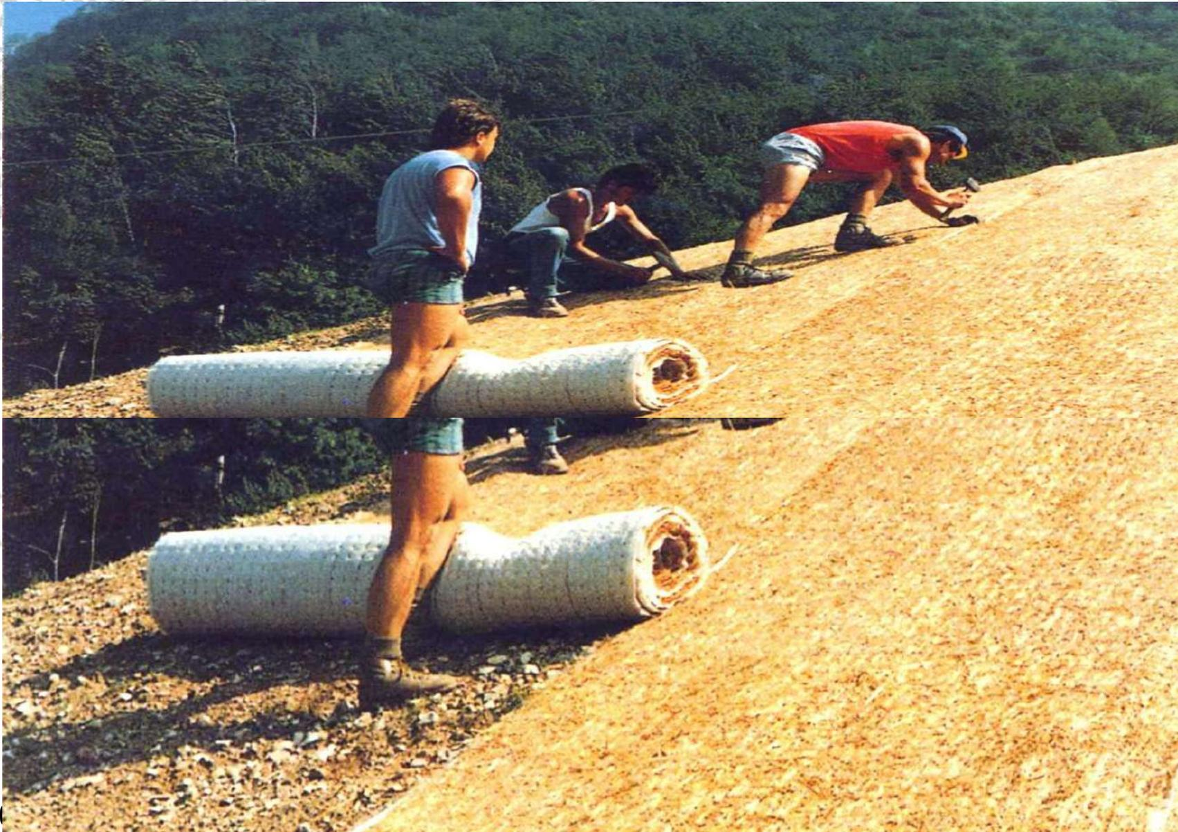
**Figura** - Scarpata in roccia arenacea a 45° con rivestimento vegetativo e stuoia organica presso stazione FS, Tarvisio-Boscoverde (UD) (da G. Sauli, 2000)
