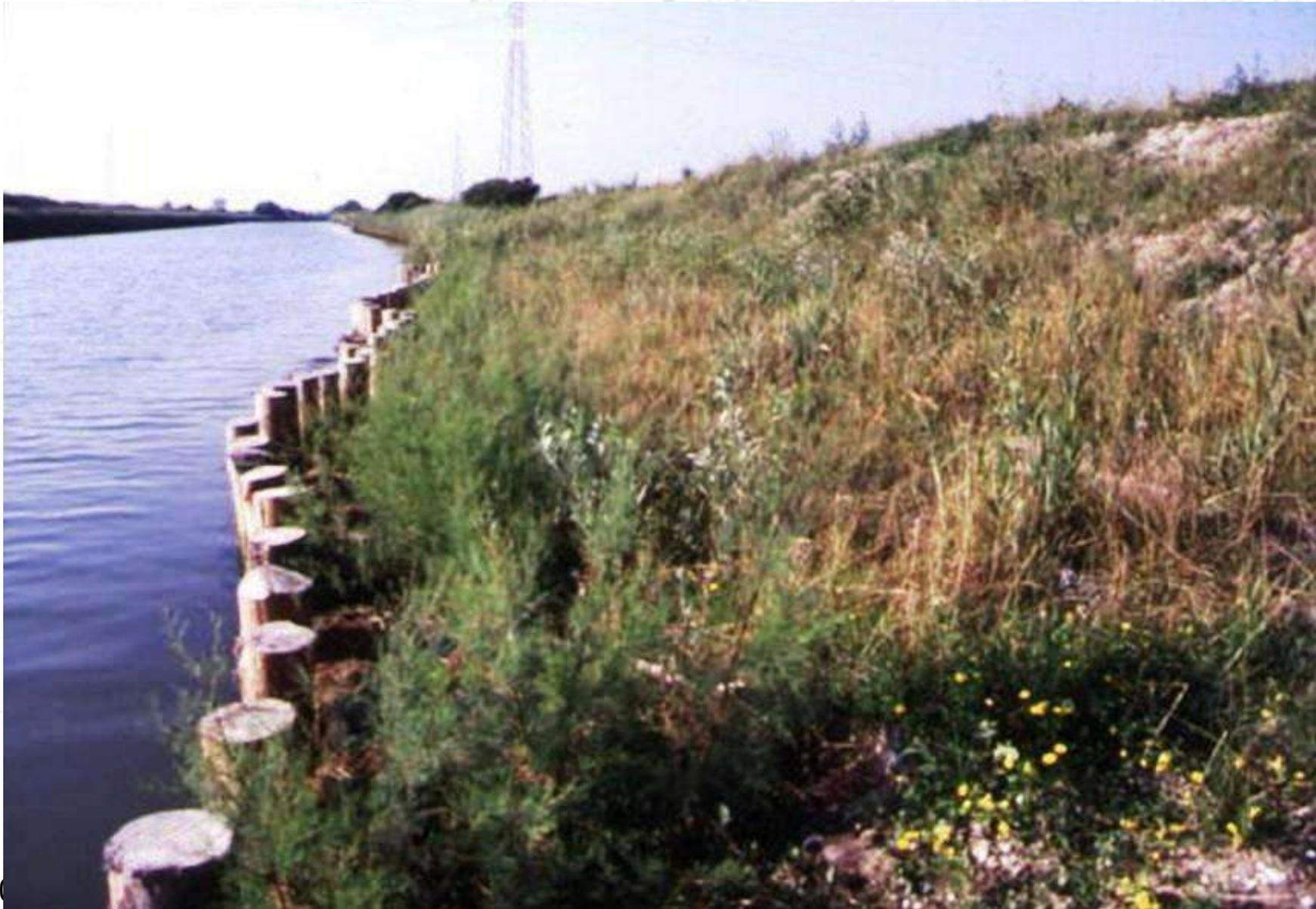
**Figura** - *Stabilizzazione delle sponde costiere lagunari a Marina di Orosei tramite la realizzazione di palificate vive spondali e trapianto di arbusti mediterranei (da P. Cornelini, 2009)*
