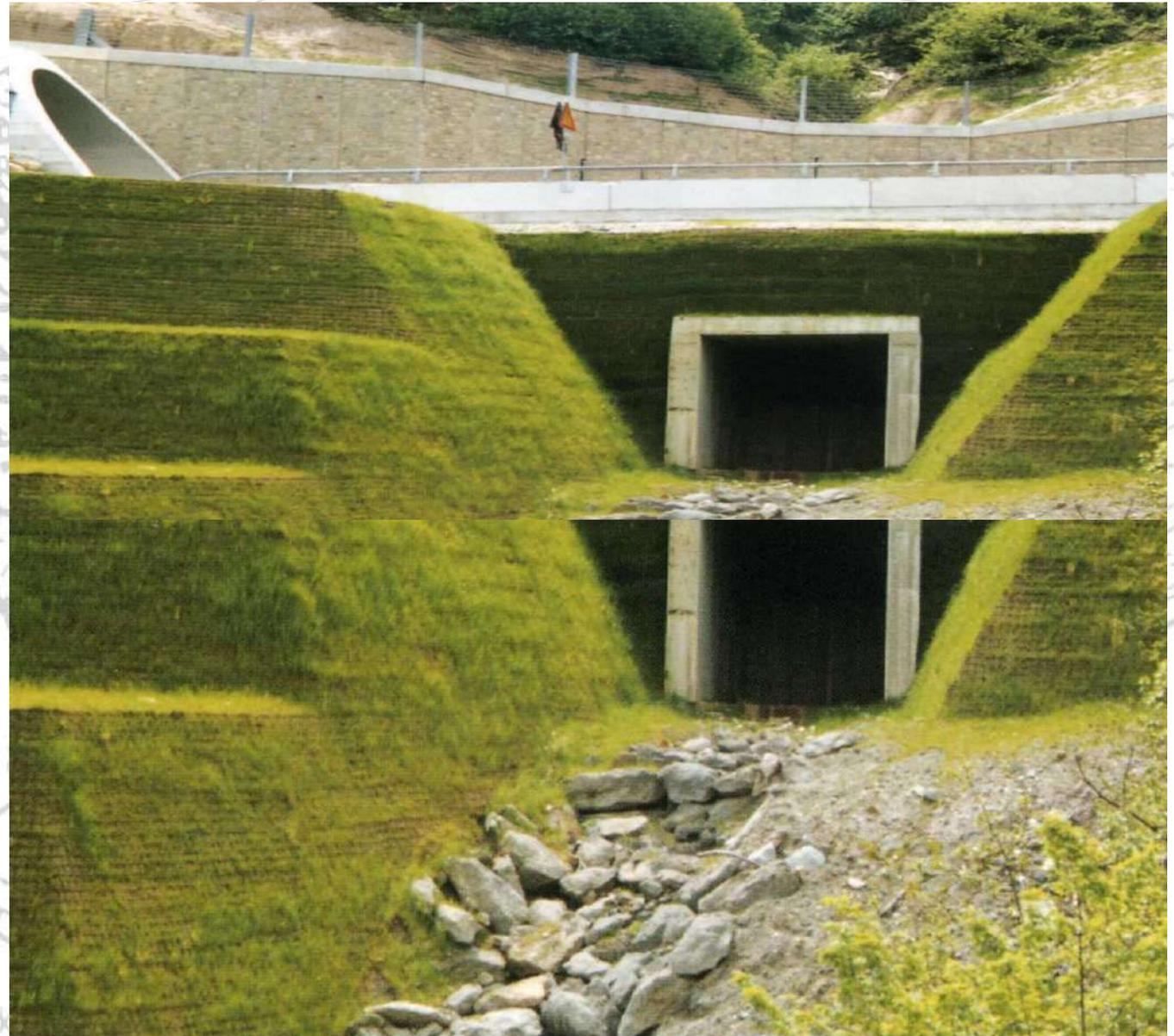
**Figura** - *Muratura in pietrame a secco rinverdita in Val Venosta*
