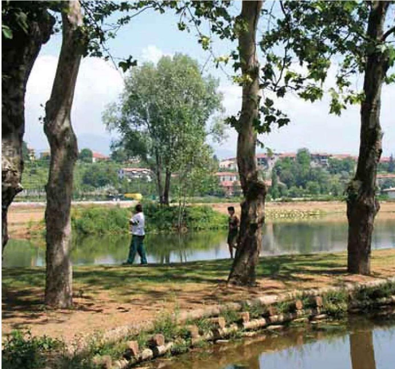
**Figura** - *la palificata viva spondale con le fascine di salice e i pali in legno*
