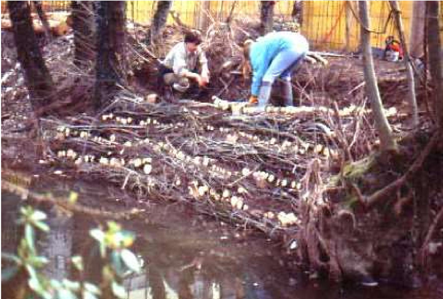
**Figura** - Ribalta viva in fase di costruzione lungo il Ticino in località Bosco Danico - Treocate (NO) (da R. Gazzola, 1982)
