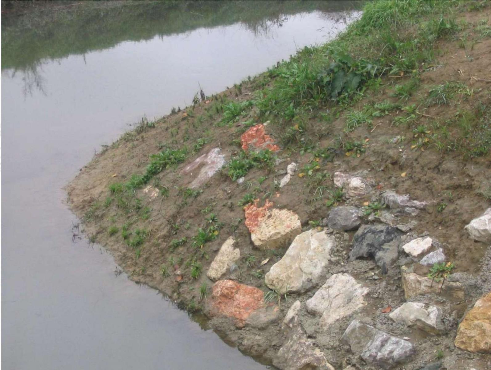
**Figura** - Intasamento di materassi "Reno" lungo il Canale Veneto ad Ariano Polesine (RO) (da MACCAFERRI, ...)
