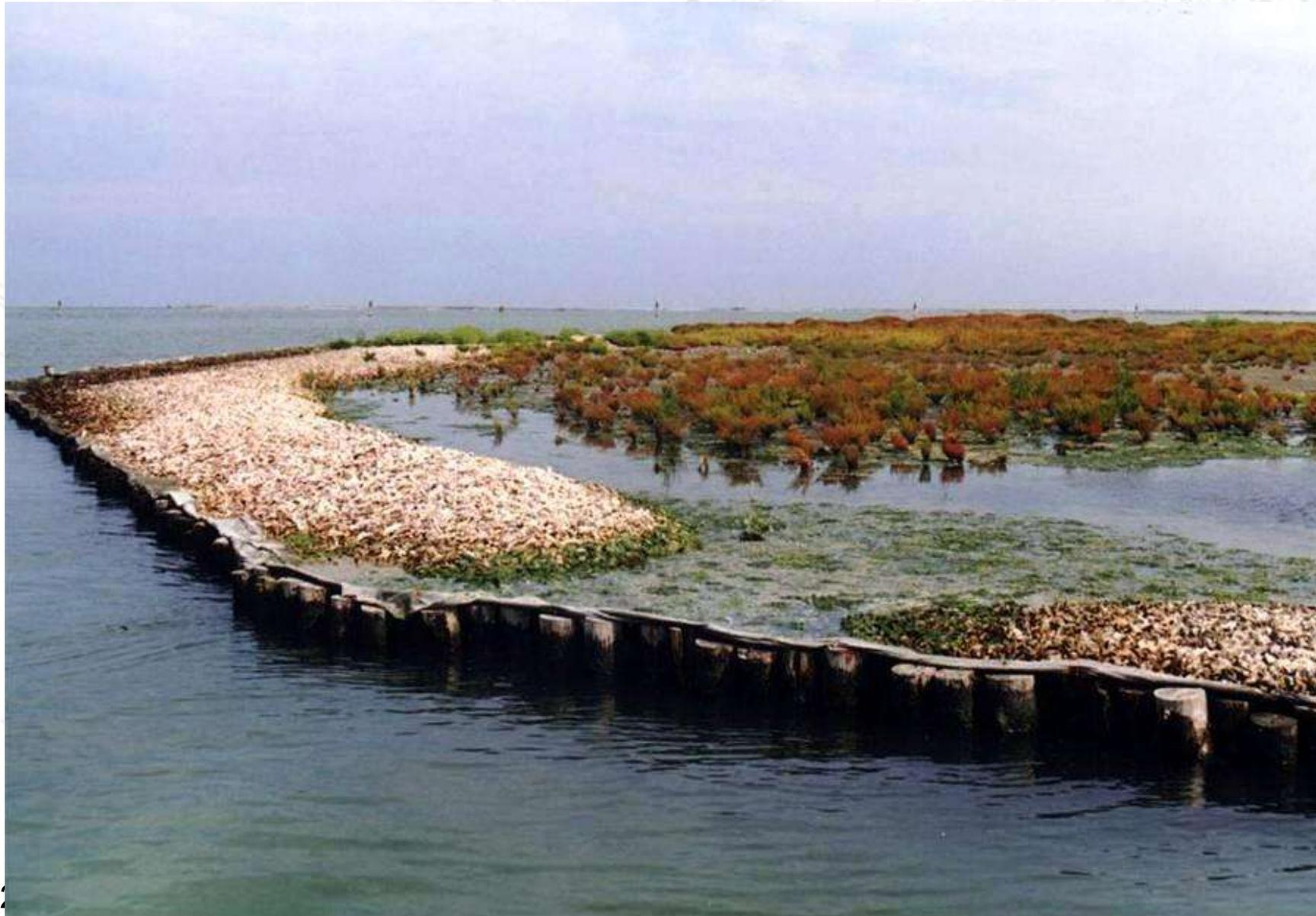
**Figura** - Ricostruzione di barene con fanghi di dragaggio, pali e geotessuti a La Vallona, RO (da G. Sauli)
