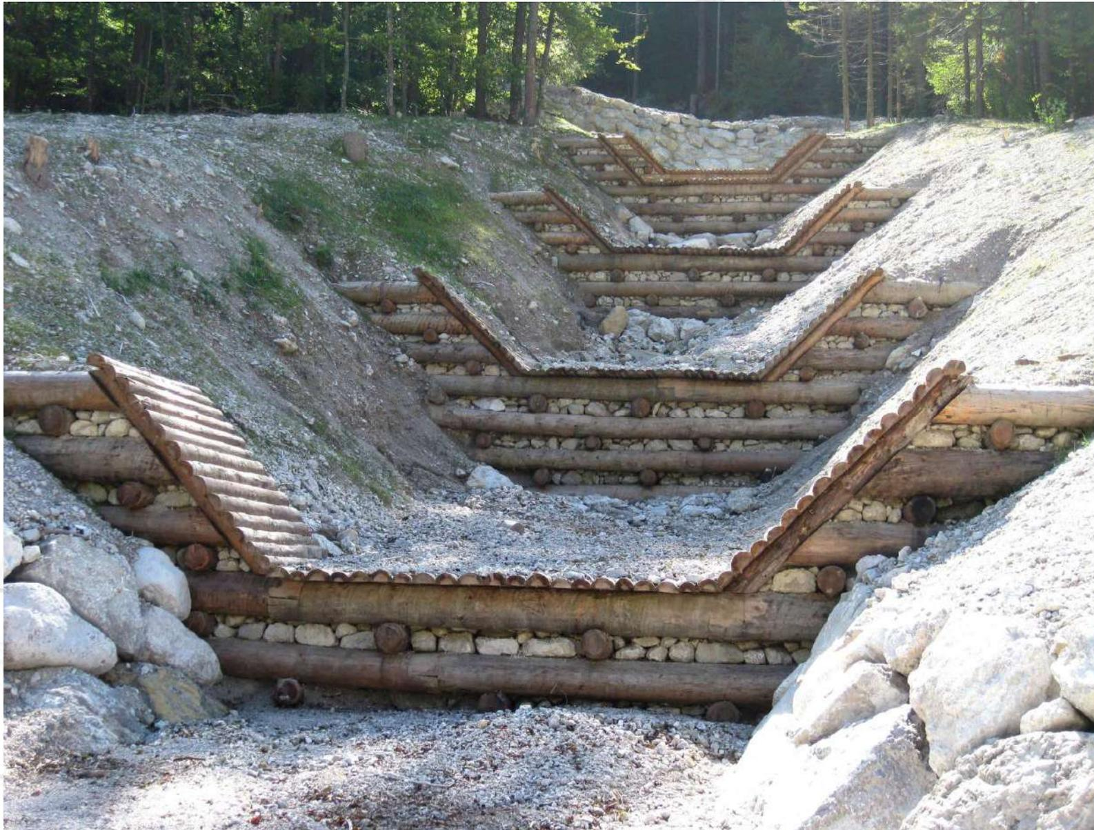
**Figura** - Veduta di una palificata spondale su un corso d'acqua sul fiume Roncaglia (CH) (-)
