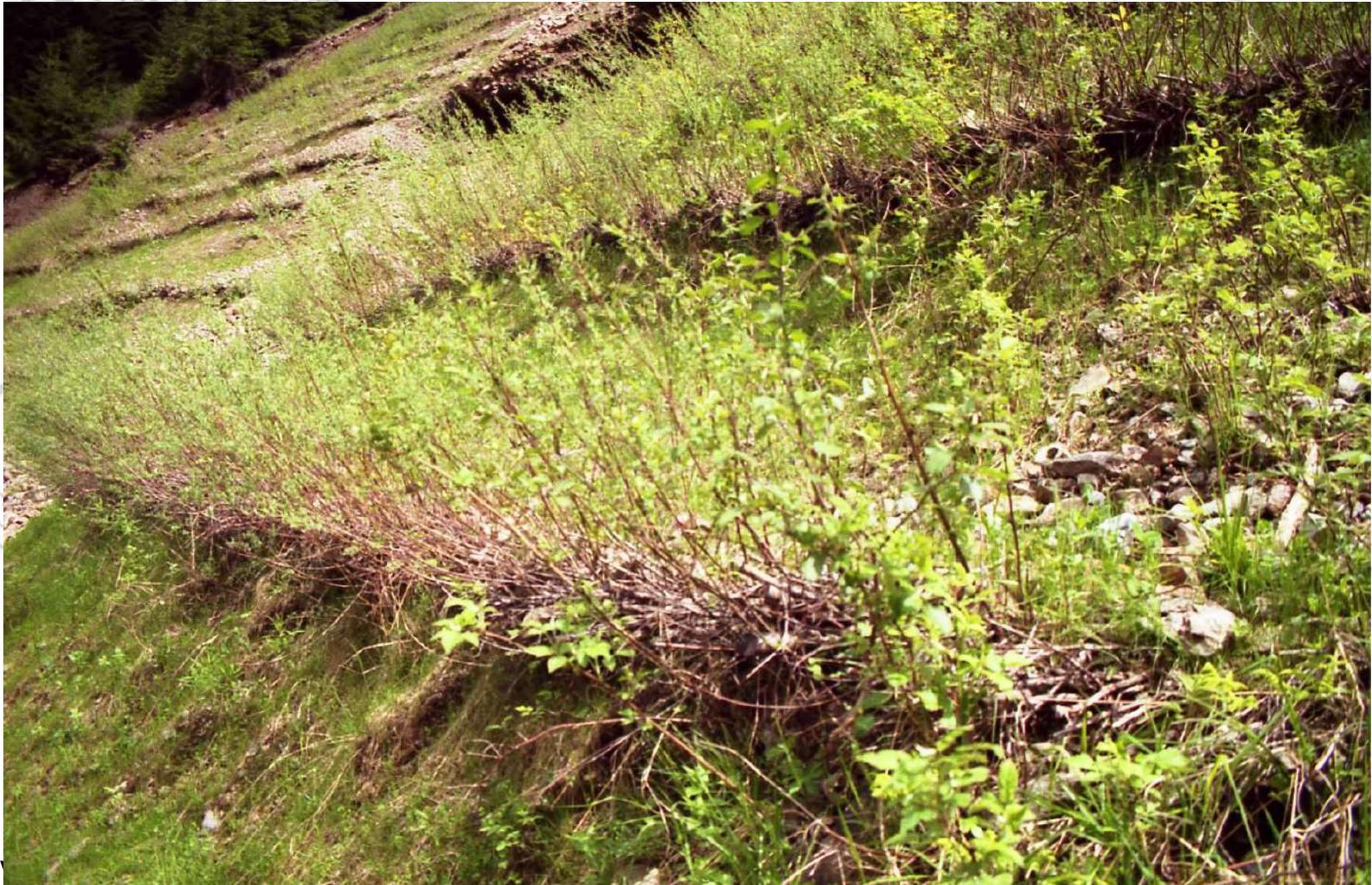
Figura - Gradonata viva a Rio Ponte di Muro (UD) (da ICE, 2001)
