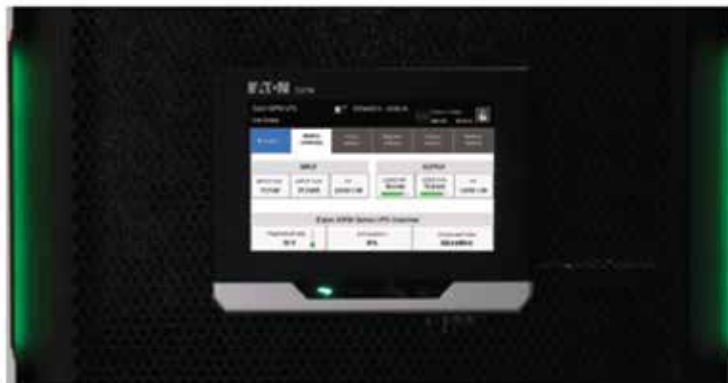
Barras de luz verde que muestran un UPS en buena condición
