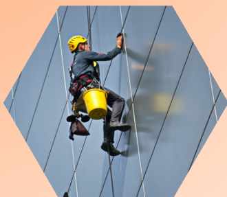
LIMPIEZA DE VIDRIOS DE ALTURA
