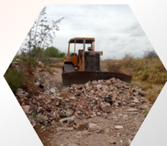
LIMPIEZA Y RETIRO DE BASURA EN TERRENOS
