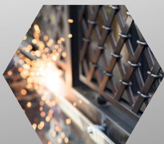
TRABAJOS DE HERRERÍA
