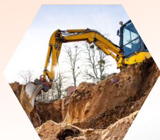
EXCAVACIONES Y CANJEO
