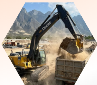
RETIRO DE ESCOMBROS CAMIÓN DE 7m 3 Y GÓNDOLA
