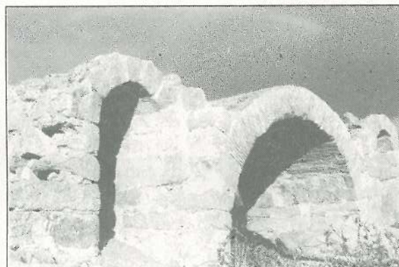
Puente Canasta sobre el río Torcón
